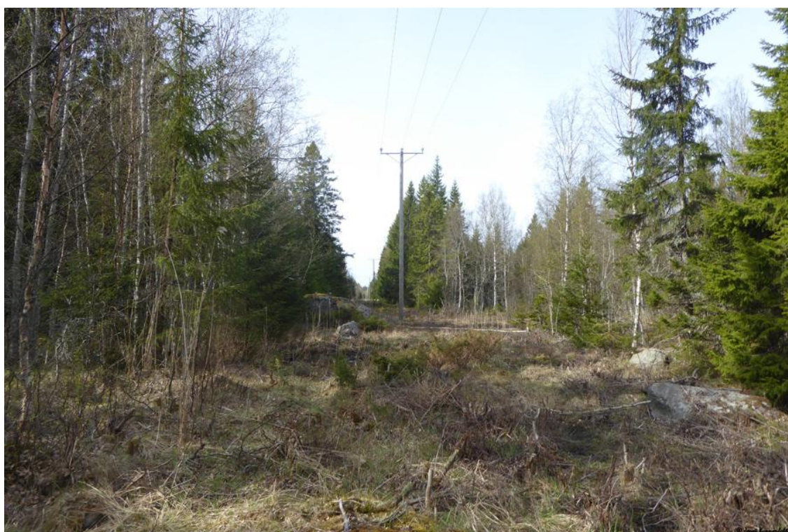
Bild 2. Elledning i den nordöstra delen av Grundskat.
