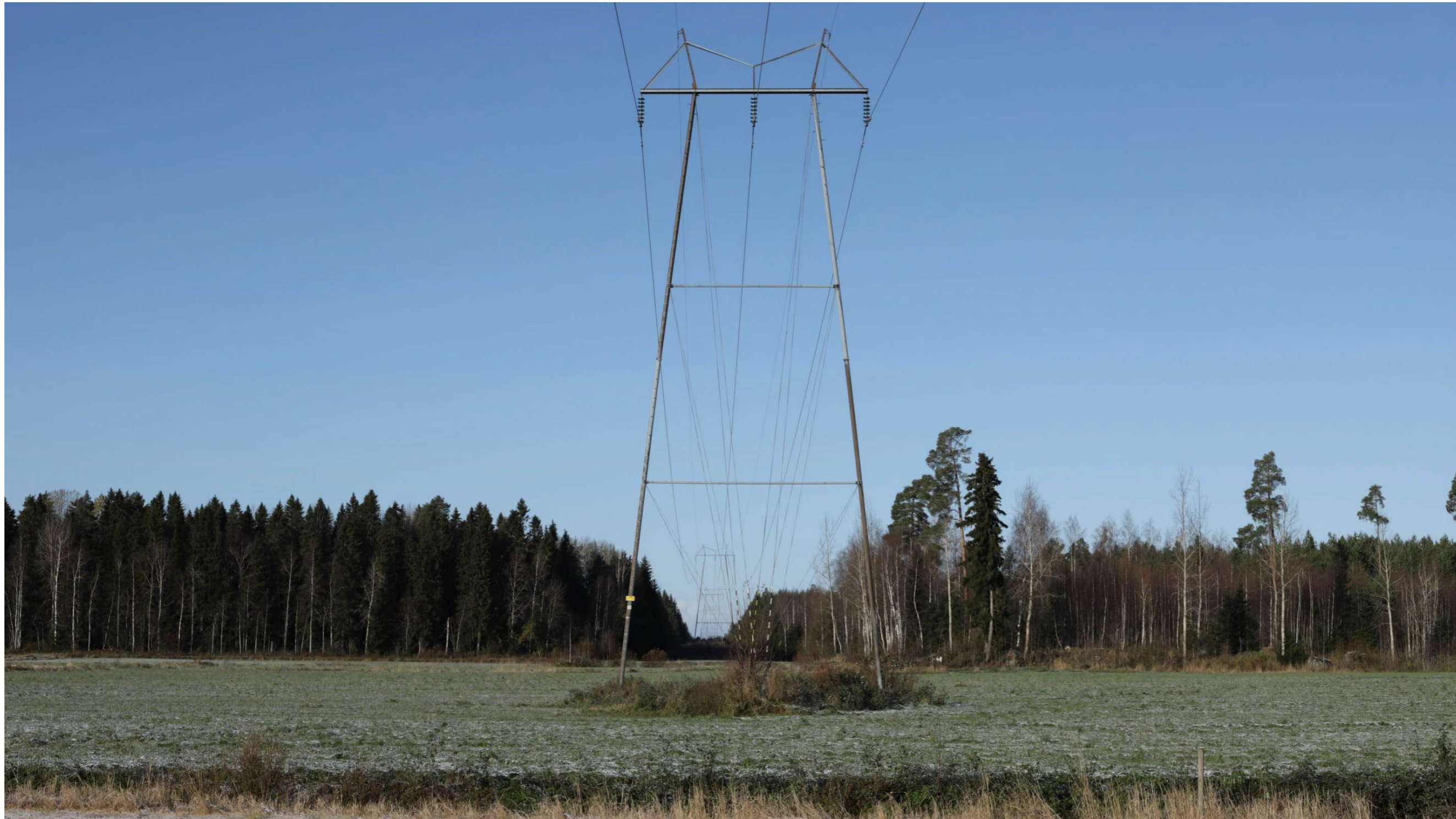
Kuva 13.3 Valokuva Finskasin alueelta olemassa olevan Jussila-Voltti 110 kV:n ilmajohdon alta voimajohdon suuntaisesti luoteeseen päin.
