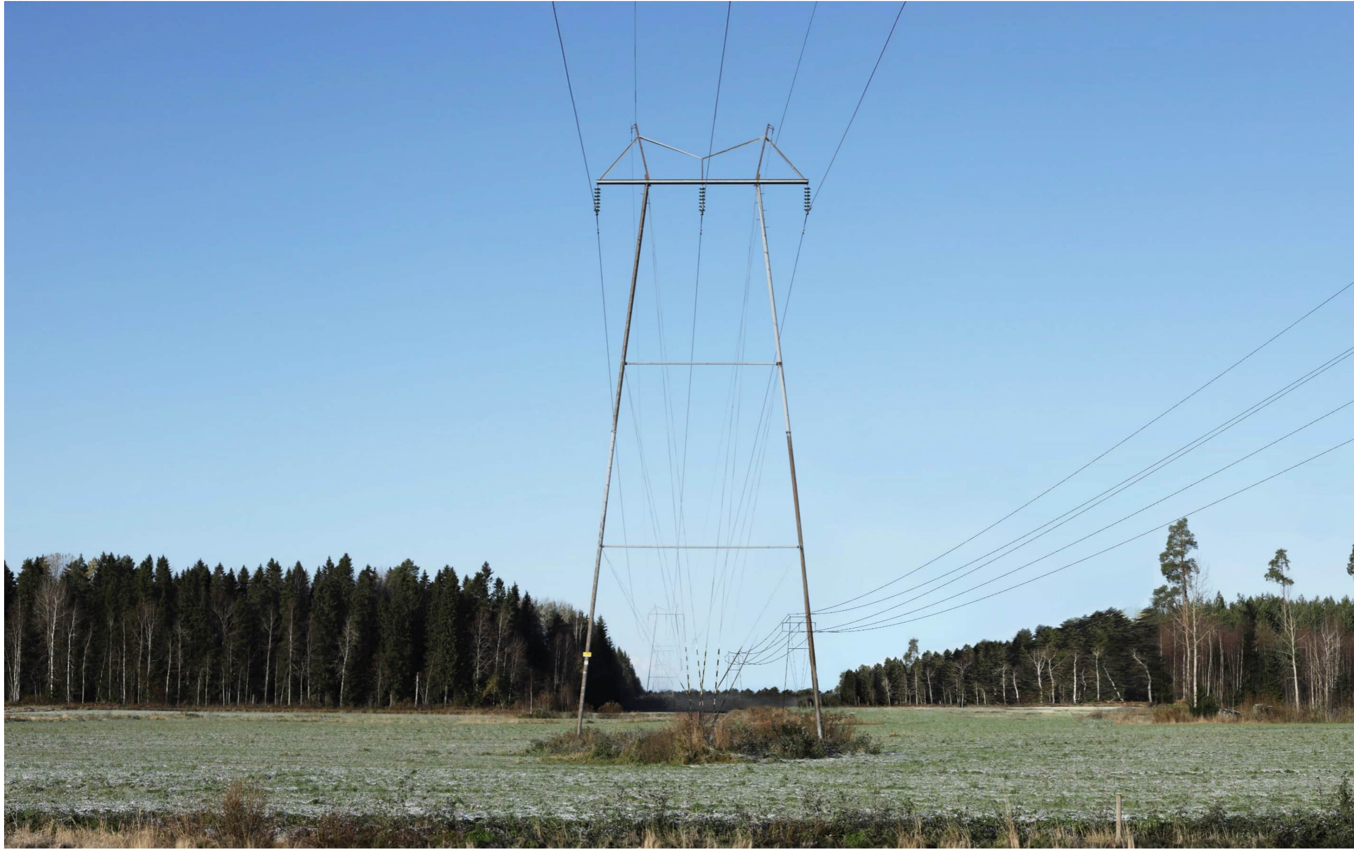
Kuva 13.4. Havainnekuva Finskas alueelta luoteeseen, jossa olemassa olevan Jussila-Voltti 110 kV:n ilmajohtoon viereen on mallinnettu toinen 110 kV:n ilmajohto uusiin pylväisiin sekä sen vaatima raivatun maastokäytävän levennys. Havainnekuvan mallinnuksesta on vastannut arkkitehti Christopher Erdman Sitowise Oy:stä.
