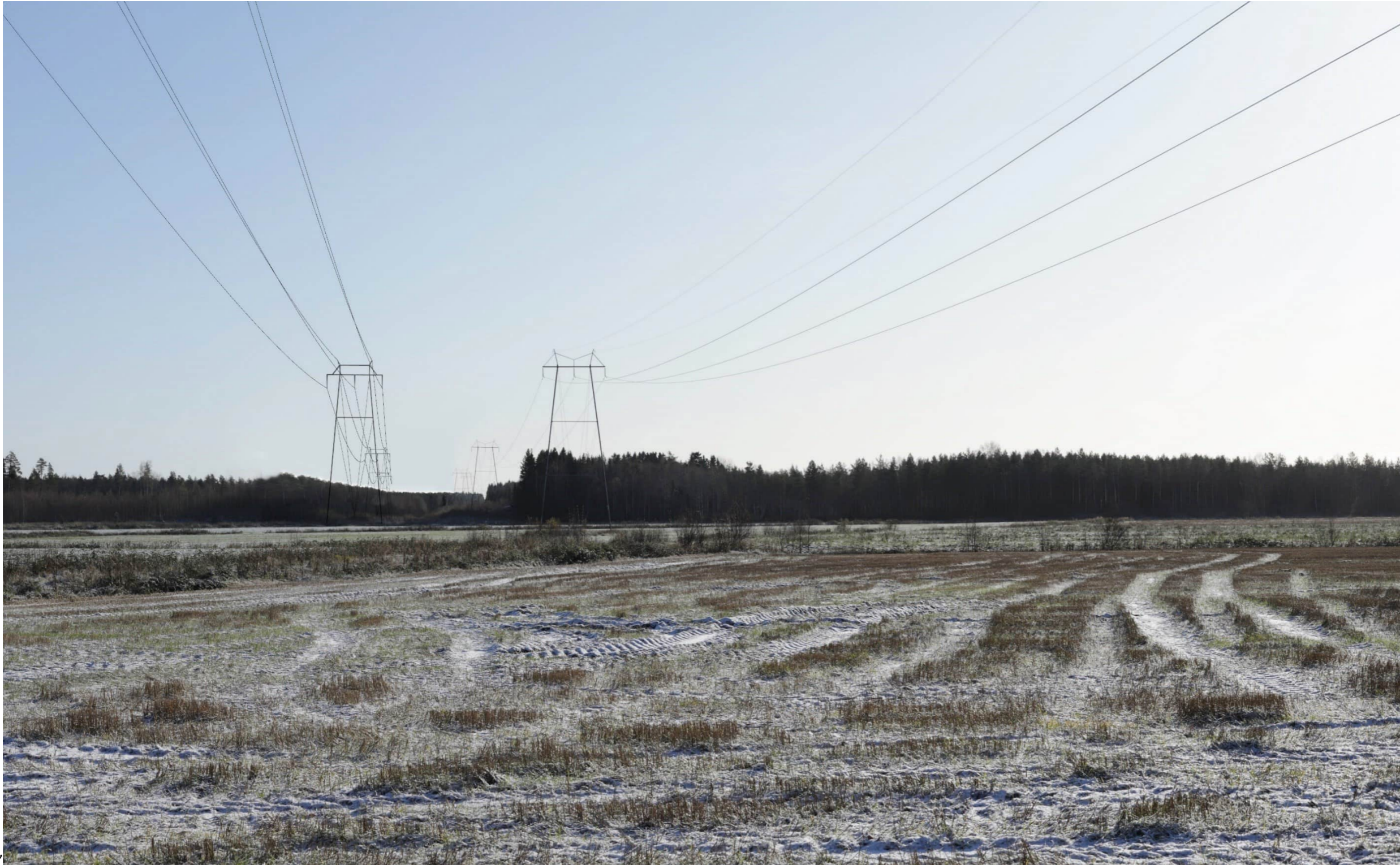
Kuva 13.2. Havainnekuva Finskasin alueelta etelään päin, jossa olemassa olevan Jussila-Voltti 110 kV:n ilmajohtoon viereen on mallinnettu toinen 110 kV:n ilmajohto uusiin pylväisiin sekä sen vaatima raivatun maastokäytävän levennys. Havainnekuvan mallinnuksesta on vastannut arkkitehti Christopher Erdman Sitowise Oy:stä.
