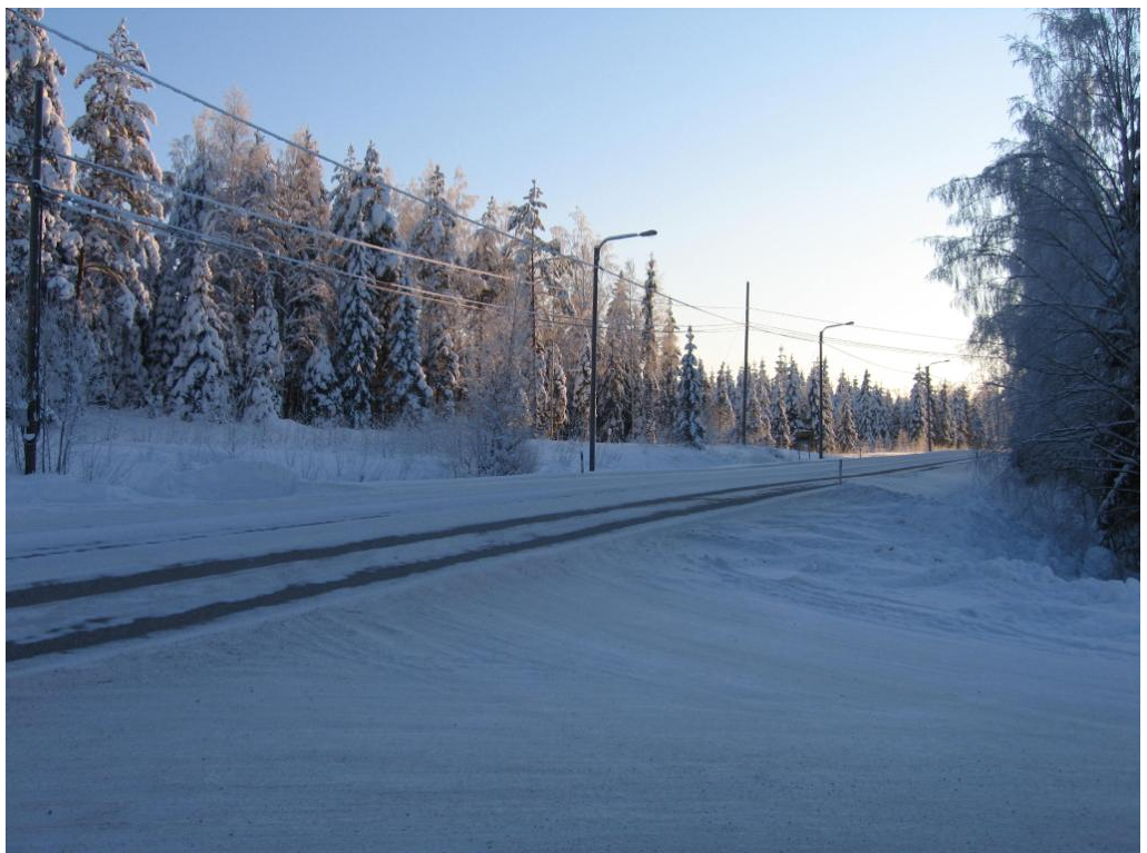
Kuva 22. Karpalotien ja Heinävedentien liittymänäkymä idän suuntaan (AIRIX Ympäristö Oy, 2012).
