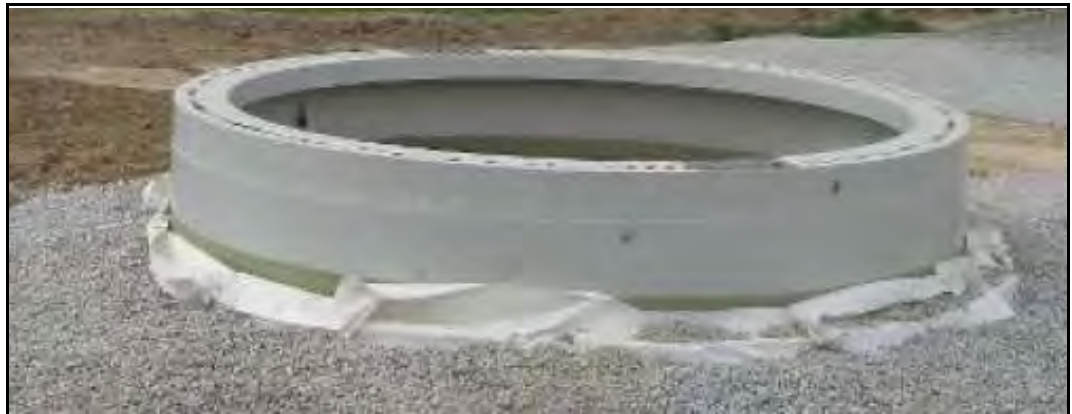
Kuva 4.15. Tuulivoimalaitoksen perustukset peitettynä.
