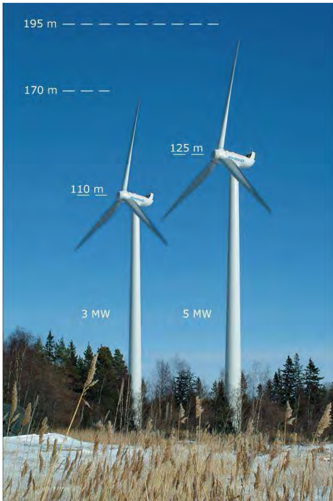
Kuva 4.3. 3 MW ja 5 MW tuulivoimalaitokset (WinWinD).
