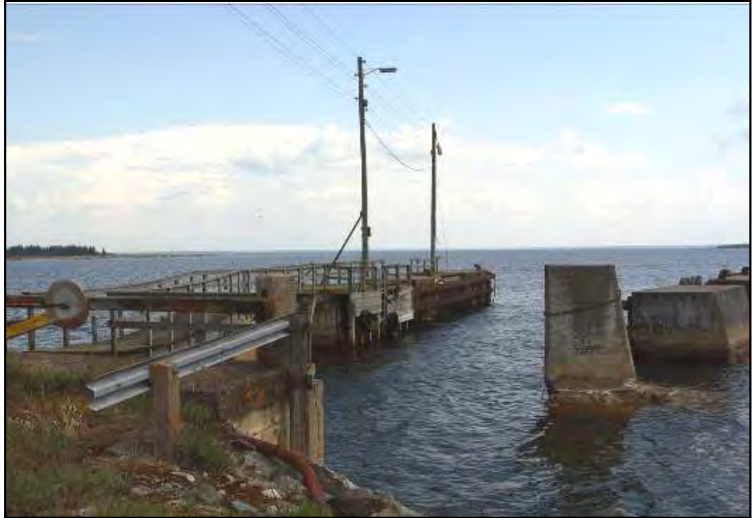
Kuva 4.9. Bergön vanha, käytöstä poistettu lossilaituri.
