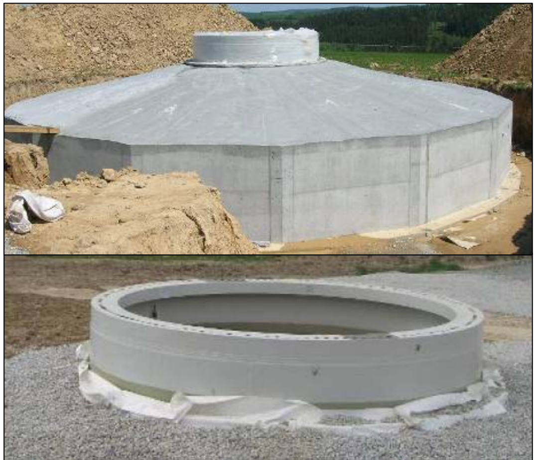
kuva 4.3. Tuulivoimalaitoksen tyypillinen perustus rakennusvaiheessa.
