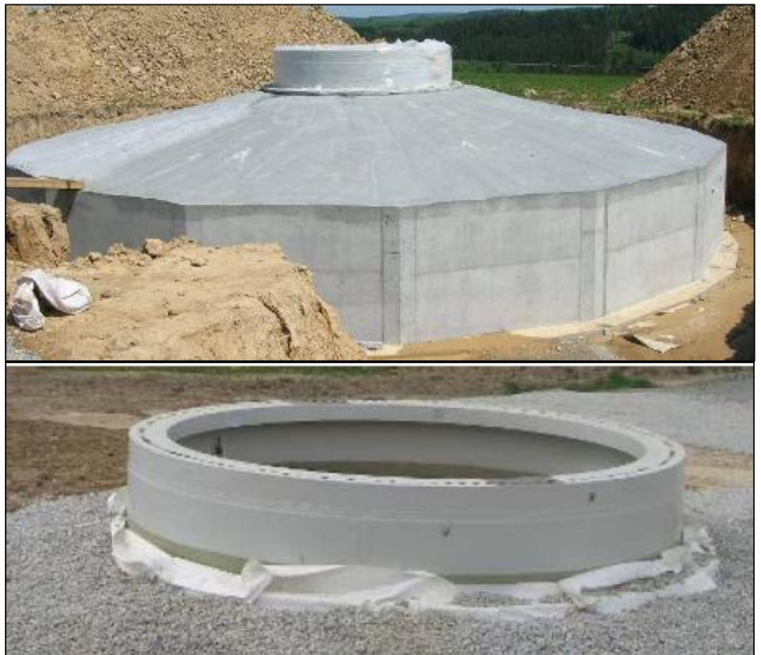
Bild 4.3. Typiskt fundament för vindkraftverk i anläggningsskedet.
