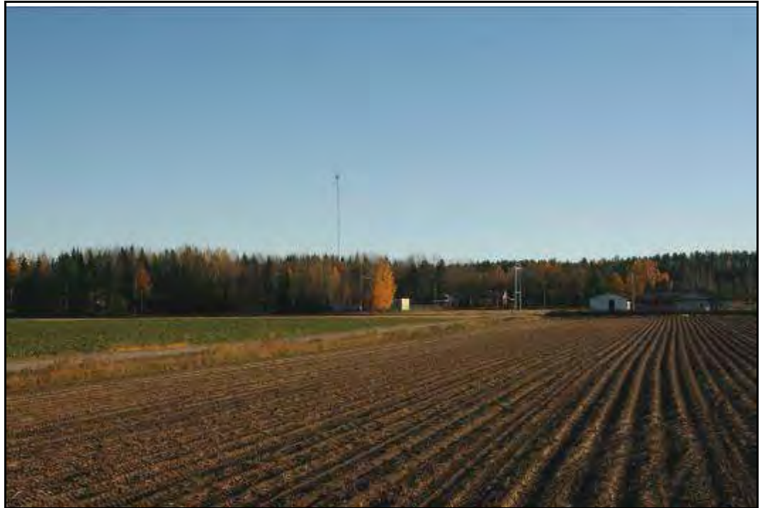
Bild 7.24. Den södra delen av kraftledningen dras över det vidsträckta jordbruksområdet i Petalax kyrkby.
