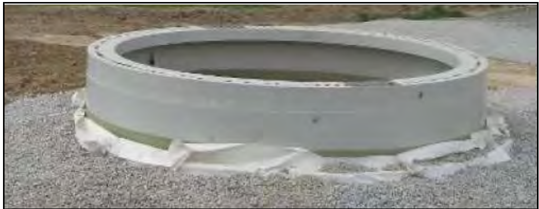
Bild 4.15. Vindkraftverkens täckta fundament.
