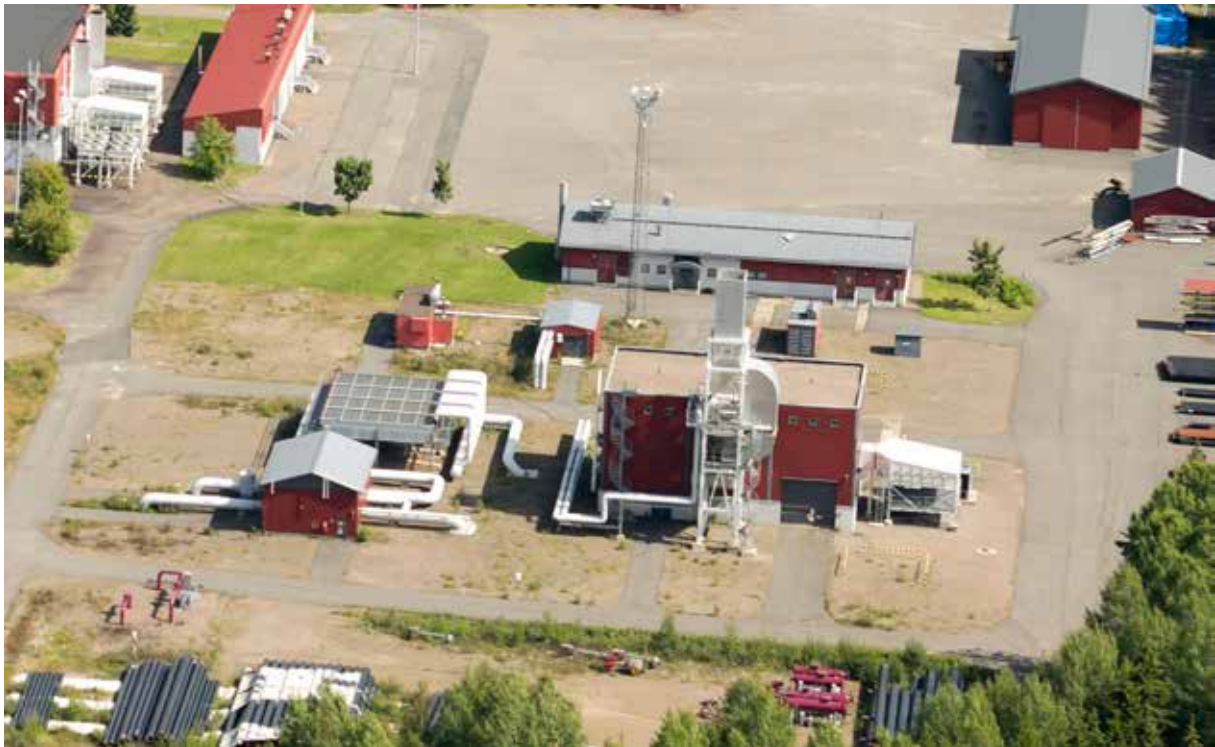
Kuva 1.18. 10 MW:n kaasuturbiinikäyttöinen putkiston kompressoriasema Kouvola Suomessa (Gasum Oy)
