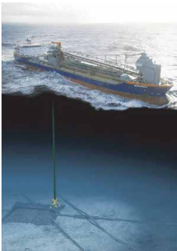
Kuva 1.17. Kiviaineksen asentaminen käyttämällä erityistä laskuputkialusta
