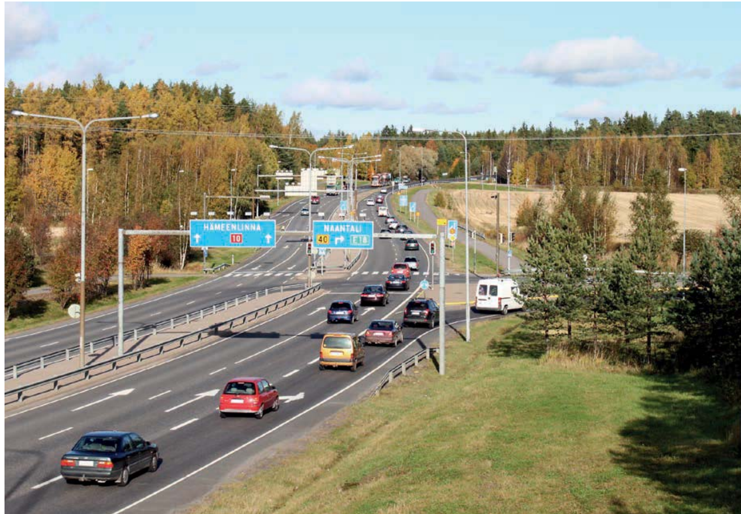
Kuva 2.10. Valtatie 10 Kauselan eritasoliittymässä.
