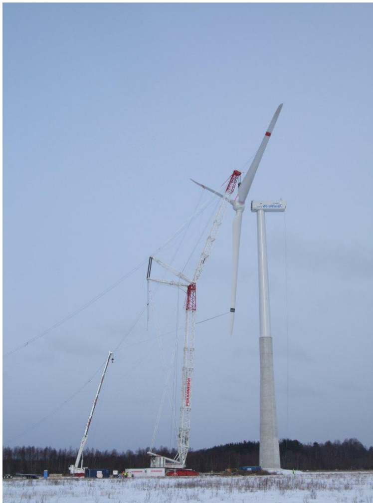
Kuva 3-8. Esimerkki tuulivoimalan roottorin asennuksesta. Tuulivoimalan torni on valmistettu betonin ja teräksen yhdistelmänä (niin sanottu hybriditorni). (Kuva: Pöyry)
