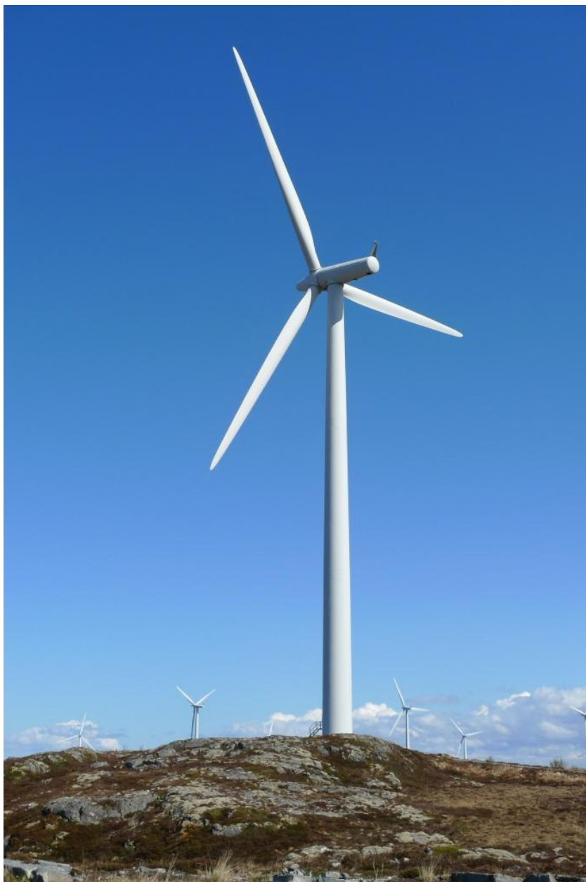
Kuva 3-6. Teräsrakenteinen tuulivoimalan torni. (Kuva: Karoliina Joensuu)
