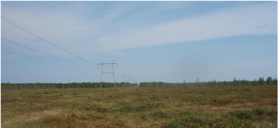
Kuva 4-53. Nuojua - Seitenoikea voimajohtolinja ylittää avosoita. Kuva Puronsuolta linjan keskivaiheilta.
