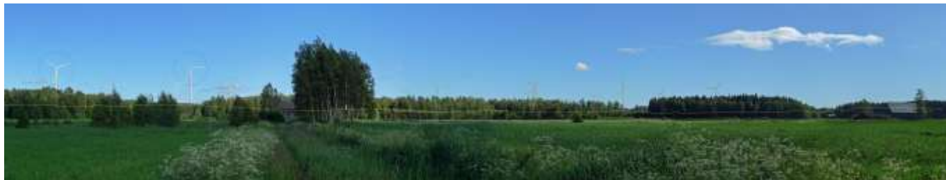
Kuva 29.5. Valokuvasovitteen 4 raakaversio hankealueen pohjoispuolelta. Etualalla vasemmalla sinisellä ympyröitynä KukkoTuuli Oy:n kaksi voimalaa.
