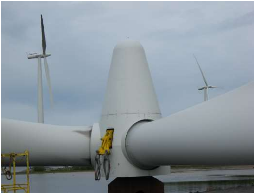
Kuva 3.19. Tuulivoimalan roottori kootaan maassa liittämällä lavat yhteen. Kuvassa roottori on kiinni telineessä ennen nostamista torniin (Kuva: Suomen Hyötytuuli Oy).
