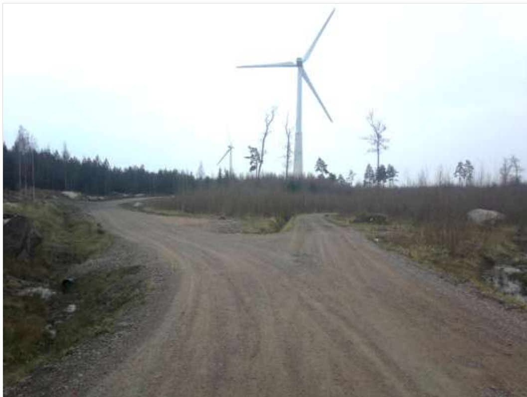
Kuva 3.11. Esimerkki tuulivoimapuiston rakennus- ja huoltotiestä. Teitä käytetään muun muassa betonin ja soran sekä voimaloiden komponenttien kuljetuksiin. Tuulivoimapuiston käyttövaiheessa teitä käytetään mm. vuosittaisissa huolloissa. (Kuva: Mattias Järvinen / FCG)
