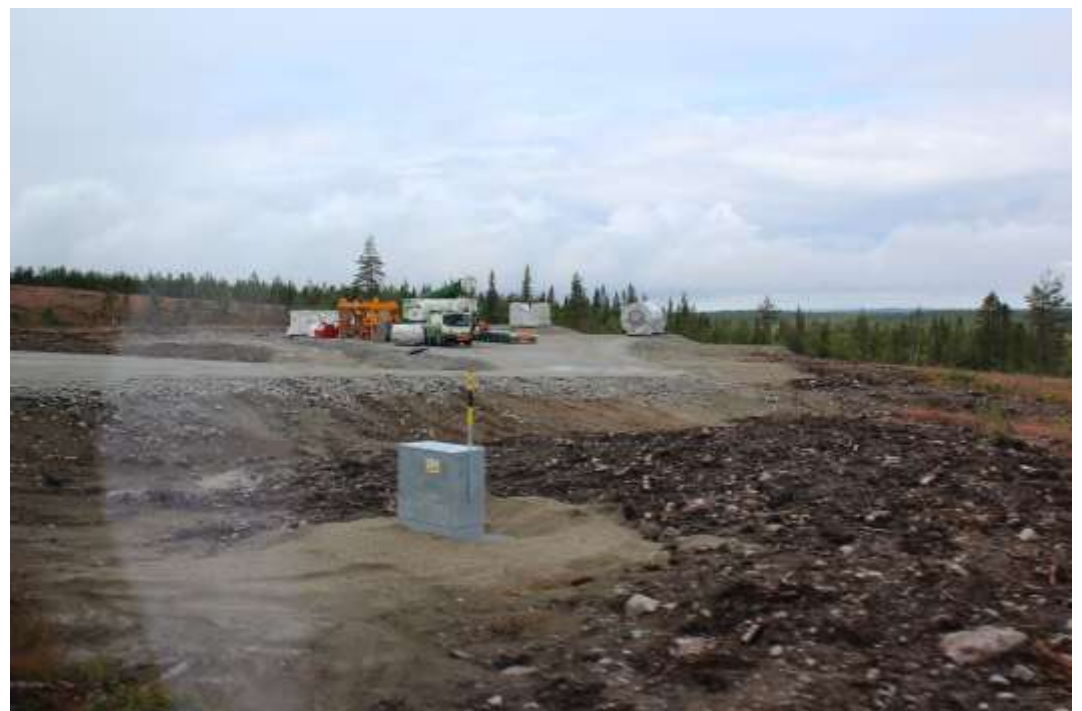
Kuva 3.18. Voimalan pystyttämisalue. Kuvassa näkyy muun muassa voimalan konehuone ja pienempi apunosturi Kuva: Hans Vadbäck / FCG).
