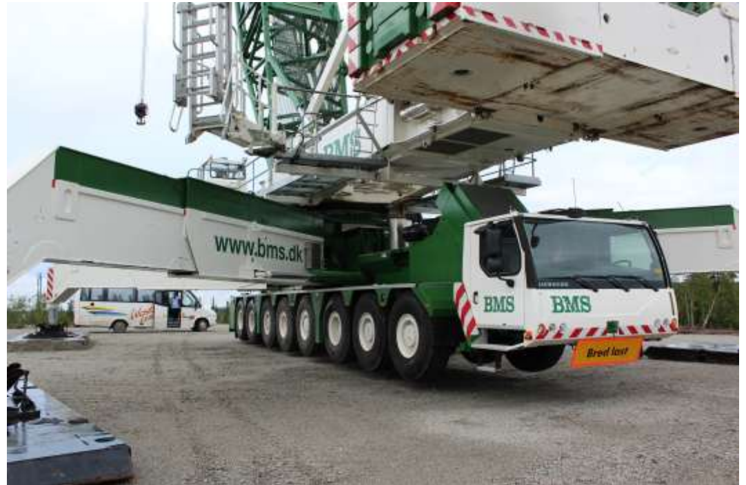
Kuva 3.17. 500 tonnin mobiilinosturi (Kuva: Hans Vadbäck / FCG).
