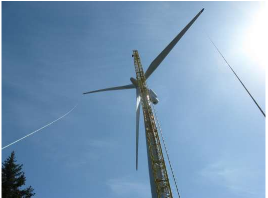
Kuva 3.20. Tuulivoimalan pystytysvaihe. Roottorin heilumista estetään kiinnittämällä apuköysi lapojen kärkeen (Kuva: Suomen Hyötytuuli Oy).
