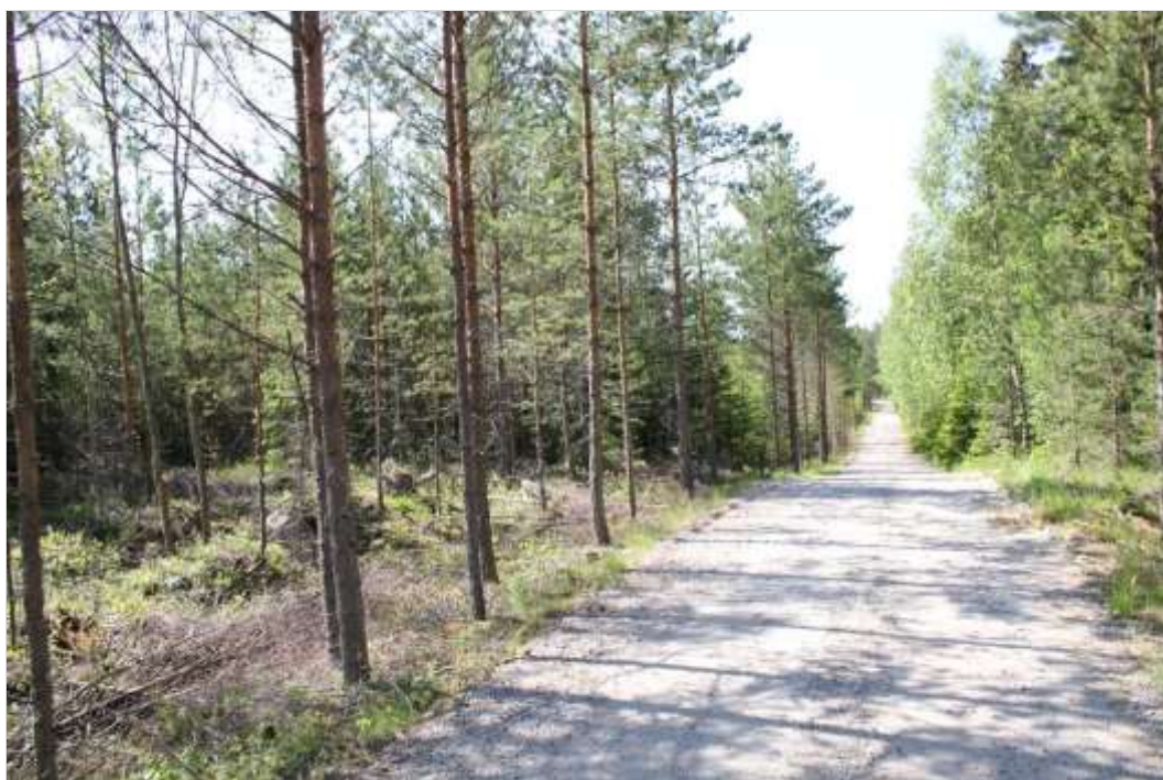
Kuva 3.9. Kakonjärven alueen nykyisiä teitä parannetaan mahdollistamaan niiden käyttöä tuulivoimapuiston rakentamisessa (Kuva: Mattias Järvinen / FCG).
