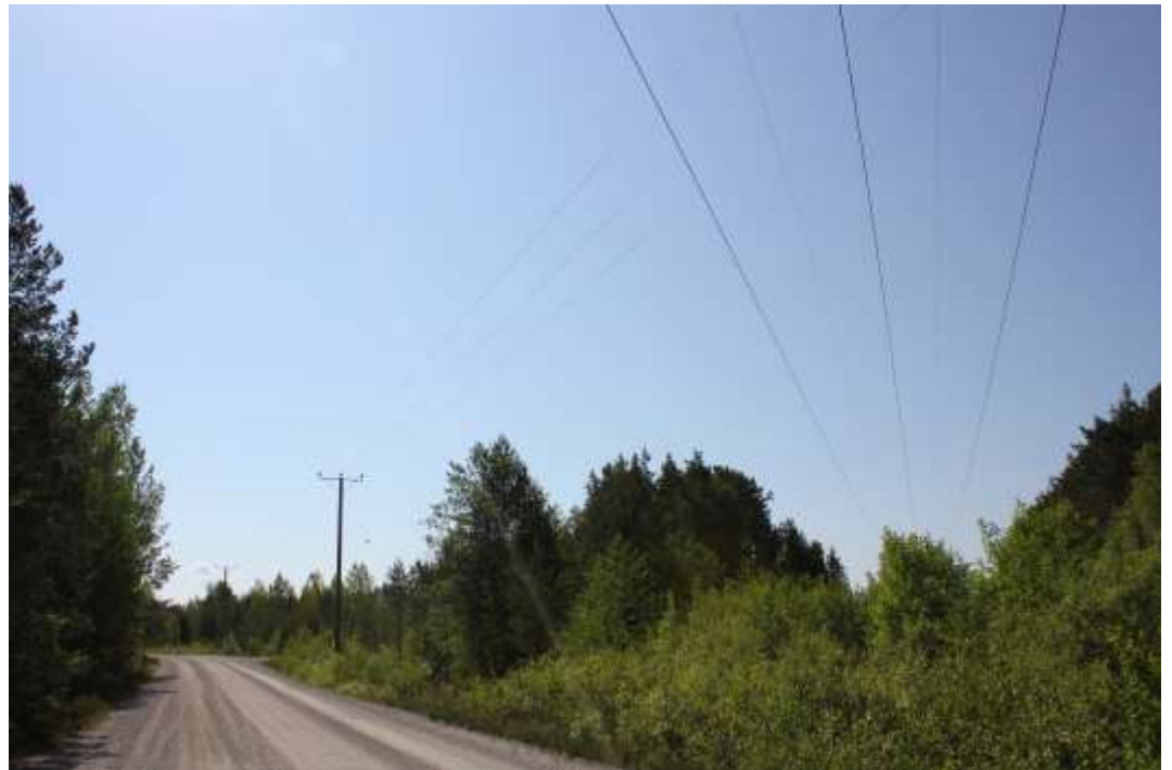
Kuva 3.14. Kakonjärven alueen tuulivoimapuisto kytketään puiston itäpuolella olevaan 110 kV voimajohtoon. Kuva otettu Untamontieltä, oikealla nykyinen tien ylittävä 110 kV ilmajohto ja vasemmalla tietä myötäilevä 20 kV ilmajohto (Kuva: Mattias Järvinen / FCG).
