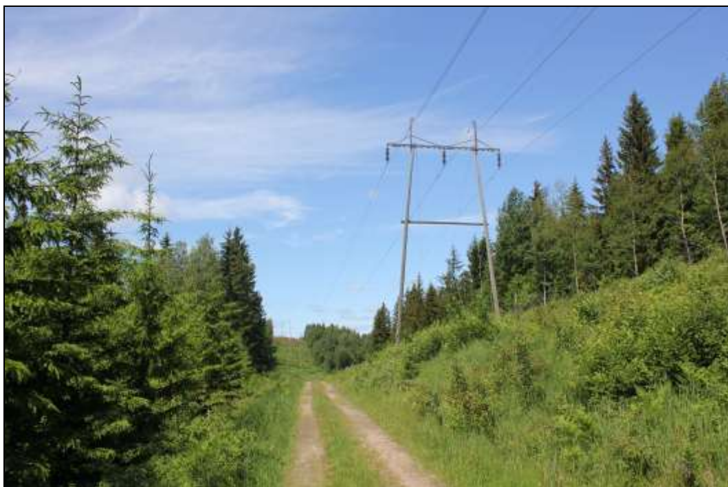
Kuva 3.16. Esimerkki 110 kilovoltin ilmajohdosta. Johtoaukealla esiintyy yleensä puun taimia ja pensasmaista kasvillisuutta (Kuva: Mattias Järvinen / FCG).
