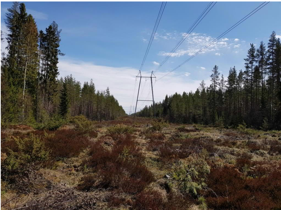
Kuva 3-1. Tyypillinen näkymä SVE1 reitin vieressä kulkevalla nykyisellä voimajohtoaukealla.
