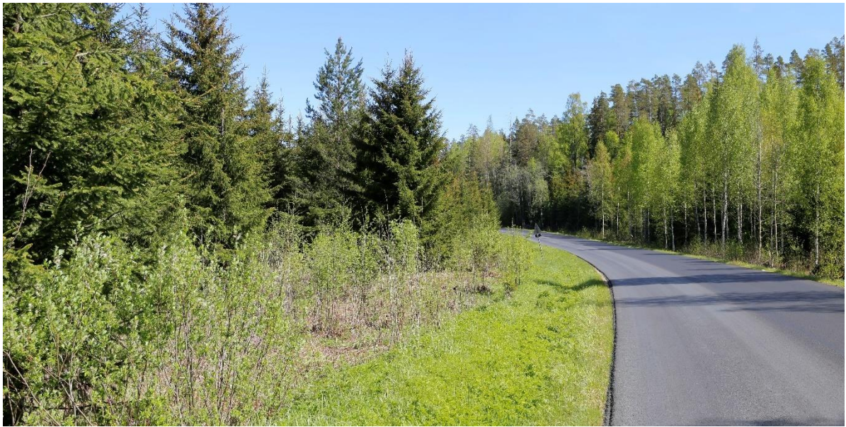
Kuva 6-5. Valokuva Hikiäntieltä soranottoalueen risteyskohdalla pohjoispuolelta kohti koillista. Kuva Ramboll 24.5.2021.
