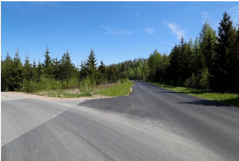
Kuva 13-2. Näkymä suunnittelualueelle vievästä risteyksestä Hikiäntielle pohjoiseen.
