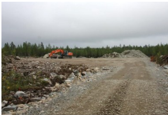
Kuva 4.17 Tuulivoimapuiston rakentaminen alkaa huoltoteiden ja pystytysalueiden rakentamisella (FCG Finnish Consulting Group Oy).
