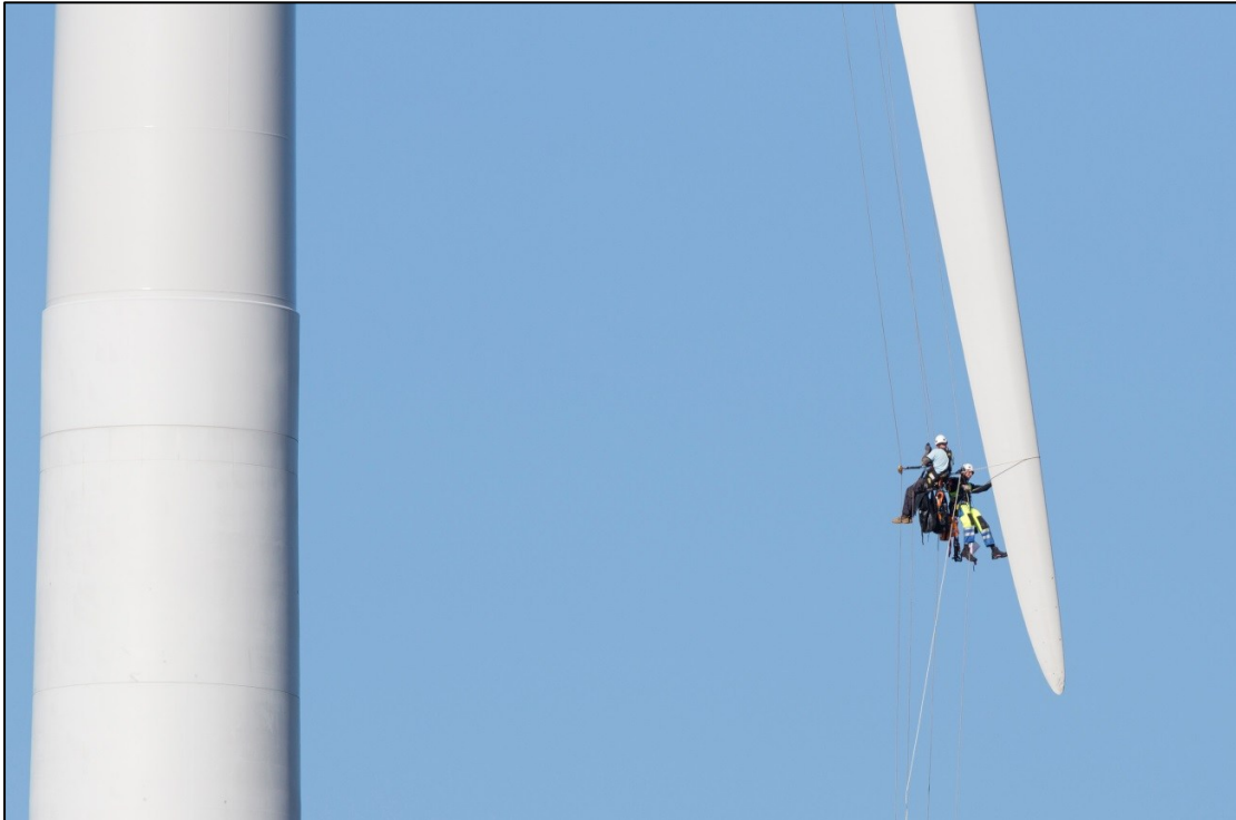
Kuva 4.24 Tuulivoimalan huoltotoimenpiteitä (FCG Finnish Consulting Group Oy).
