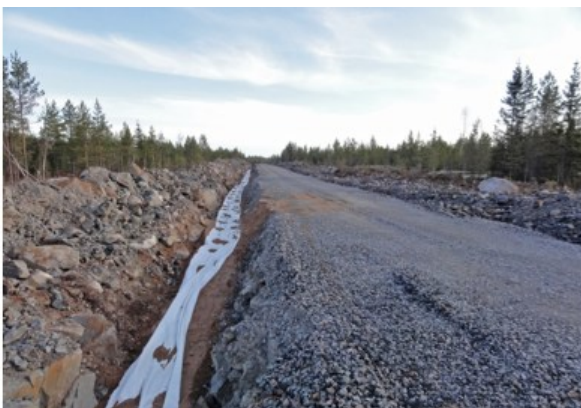
Kuva 4.18 Maakaapelit upotetaan huoltoteiden yhteyteen (FCG Finnish Consulting Group Oy).
