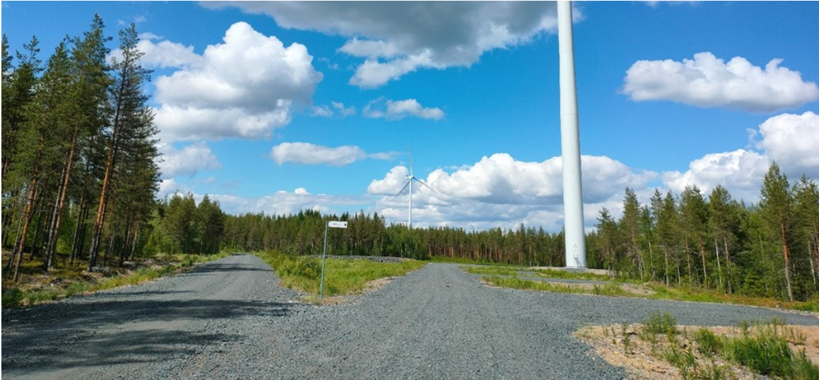
Kuva 13.18 Keson tuulipuiston alueella voimalapaikat, nostoalueet ja useat rinnakkaiset huoltotiet muodostavat laajoja avoimia alueita, joiden reunat ovat joutomaaluonteiset.
