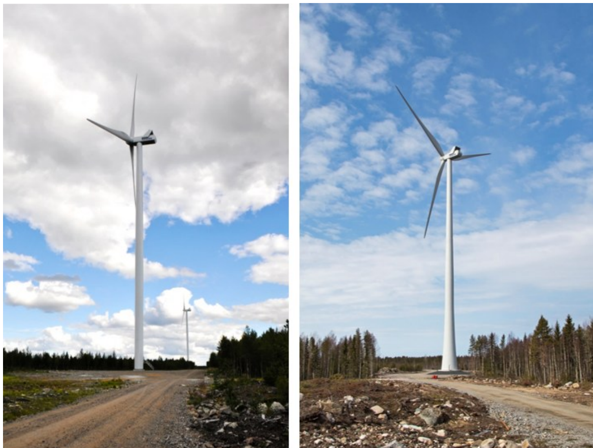
Kuva 4.2 Vasemmalla on esimerkki teräslieriötornista ja oikealla hybriditornista (FCG Finnish Consulting Group Oy).
