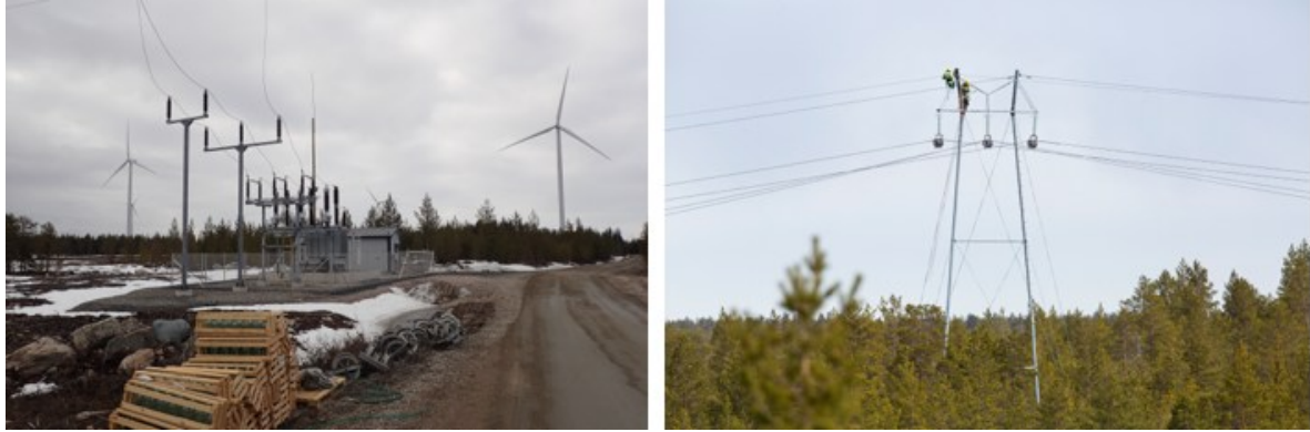
Kuva 4.22 Sähköaseman ja voimajohdon rakentamista (FCG Finnish Consulting Group Oy).
