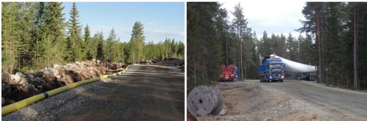
Kuva 4.7 Vasemmalla esimerkki tuulivoimapuiston rakennus- ja huoltotiestä. Oikealla tuulivoimalan osia kuljetetaan erikoiskuljetuksina (FCG Finnish Consulting Group Oy).
