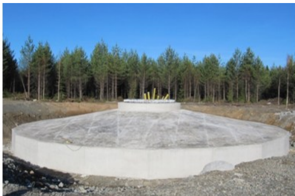
Kuva 4.19 Tuulivoimalan perustusten rakentamista (FCG Finnish Consulting Group Oy).
