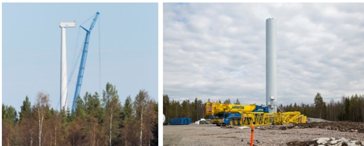
Kuva 4.20 Tuulivoimalan kokoamista (FCG Finnish Consulting Group Oy).
