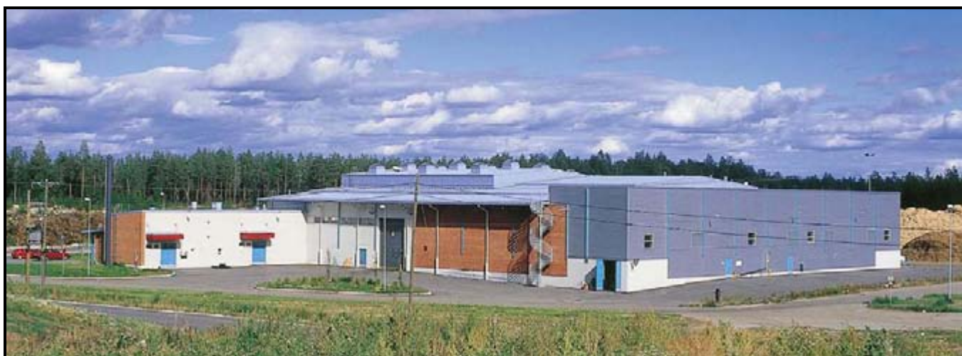
Kuva10. YTV:n jätteenkäsittelykeskuksessa Espoon Ämmässuolla sijaitseva biojätteen käsittelylaitos
