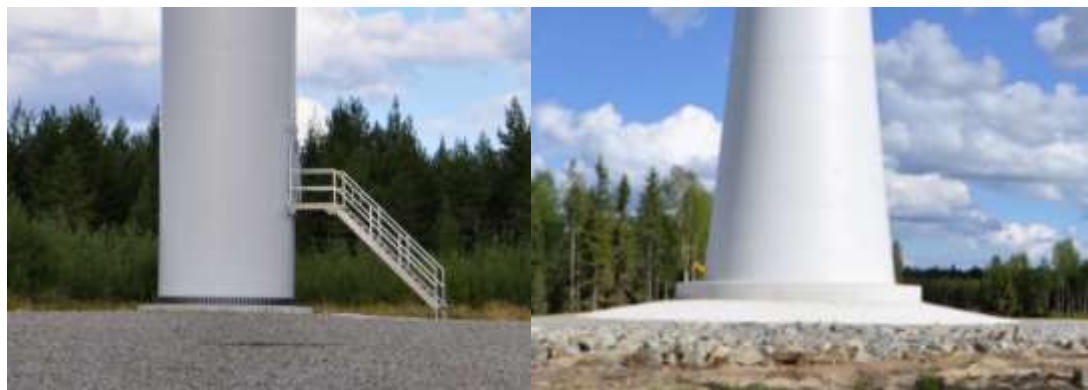
Kuva 5.2. Mallikuvapari voimaloiden perustuksista valmiina. Vasemmalla teräslieriötorni ja oikealla hybriditorni.
