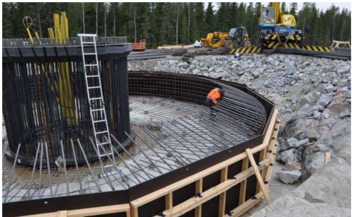
Kuva 5.6. Tuulivoimalan perustusten rakentamista. (Kuva: Leila Väyrynen, FCG)
