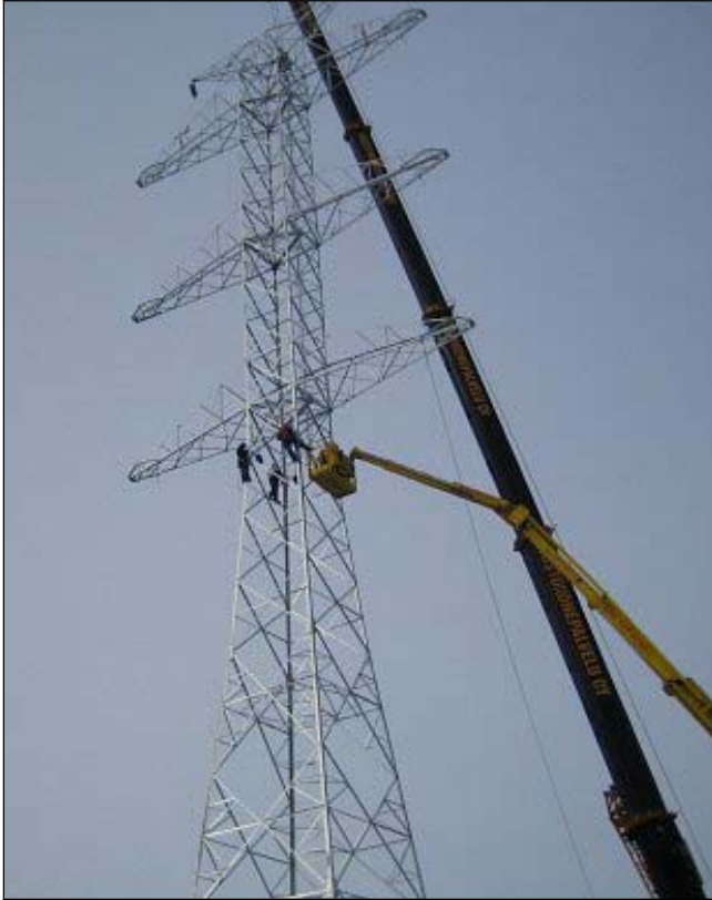
Kuva 8. Jännitetasoltaan 400 kV kahden voimajohdon Tannenbaum-tyyppisen pylvään pystytystä nostureilla.
