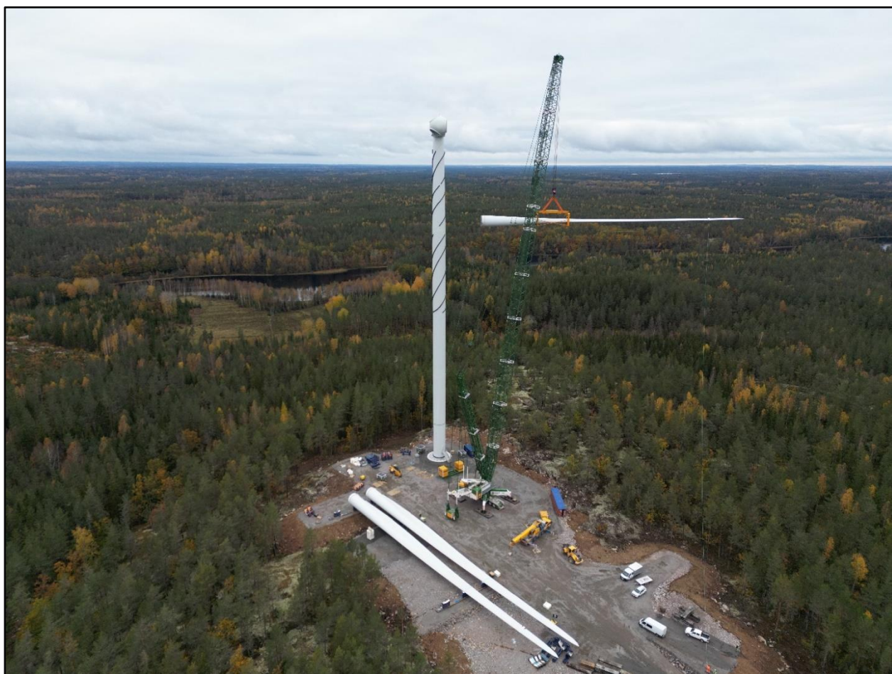
Kuva 17. Voimalan kokoaminen (Eurowind Energy 2023).
