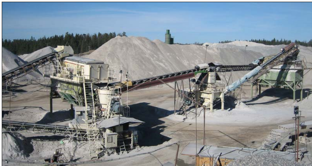
Kuva 4-7. Toiminta hankealueilla vaihtelee mm kiviaineksen kysynnän mukaan. Betonin, tiilen ja asfaltin murskausta on suunniteltu tehtäväksi 1-3 kertaa vuodessa. Palovuoren toiminta-alue.
