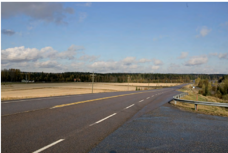
Kuva 5.39. Mt 130 Haavistontien liittymästä pohjoiseen.
