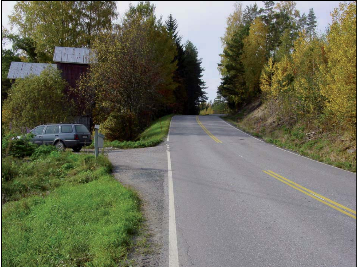
Kuva 8-19. Harattan alueelta tulevan tieyhteyden liittymä idästä päin katsottuna. Kuvattu 26.9.2008.
