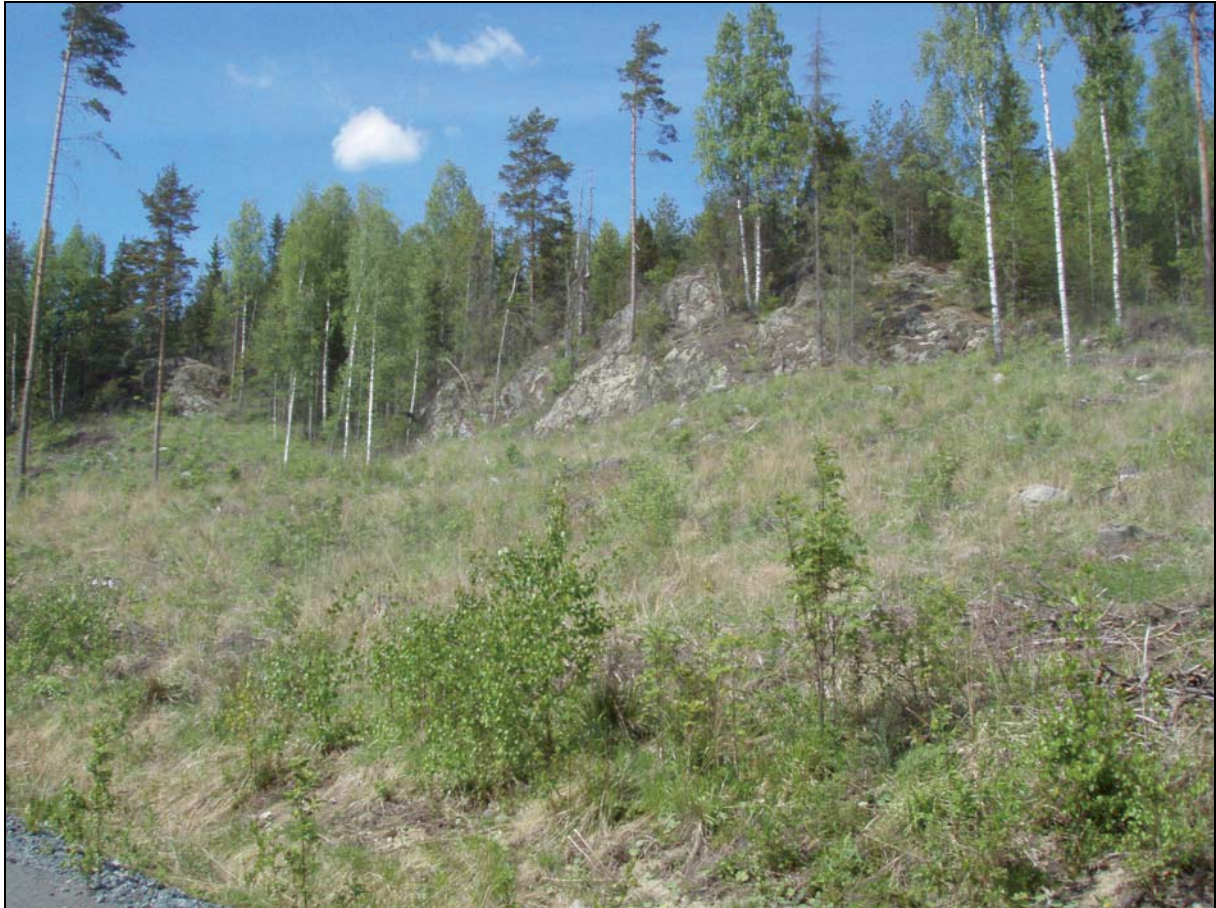
Kuva 8-14. Jukolan eteläpuoliset kalliojyrkänteet, jotka sijoittuvat suojavyöhykkeelle. Kuvattu 29.5.2008.
