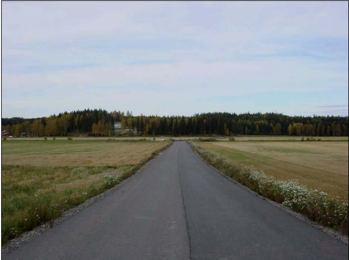
Kuva 8-15. Näkymä Arlammintien alkupäästä Jukolan alueelle päin katsottaessa. Kuvattu 26.9.2008.
