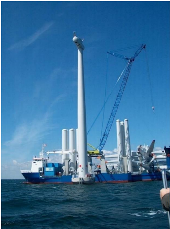
Kuva 7. Merituulivoimalan asennus (wpc, 2008).
