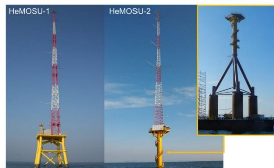
Kuva 6. Mittausmastojen vaihtoehtoiset perustustyyppit (K.-Y. Oh et al., 2018).
