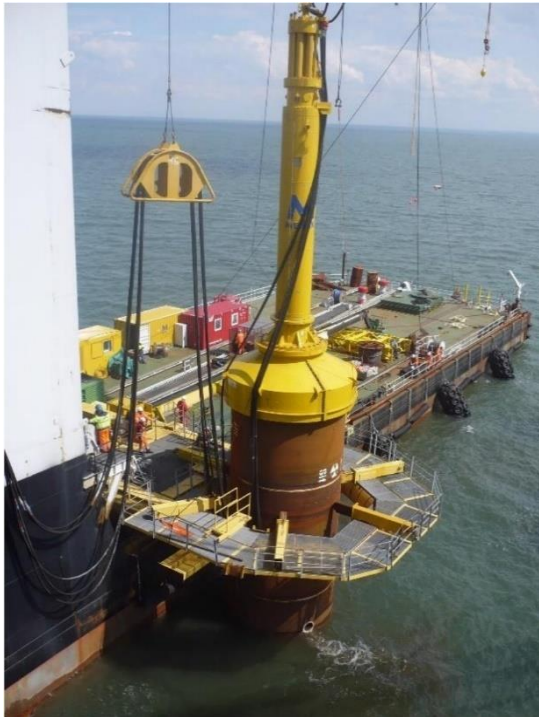
Kuva 4. Monopile-perustuksen asennus. Kuva: wpd (2013)
