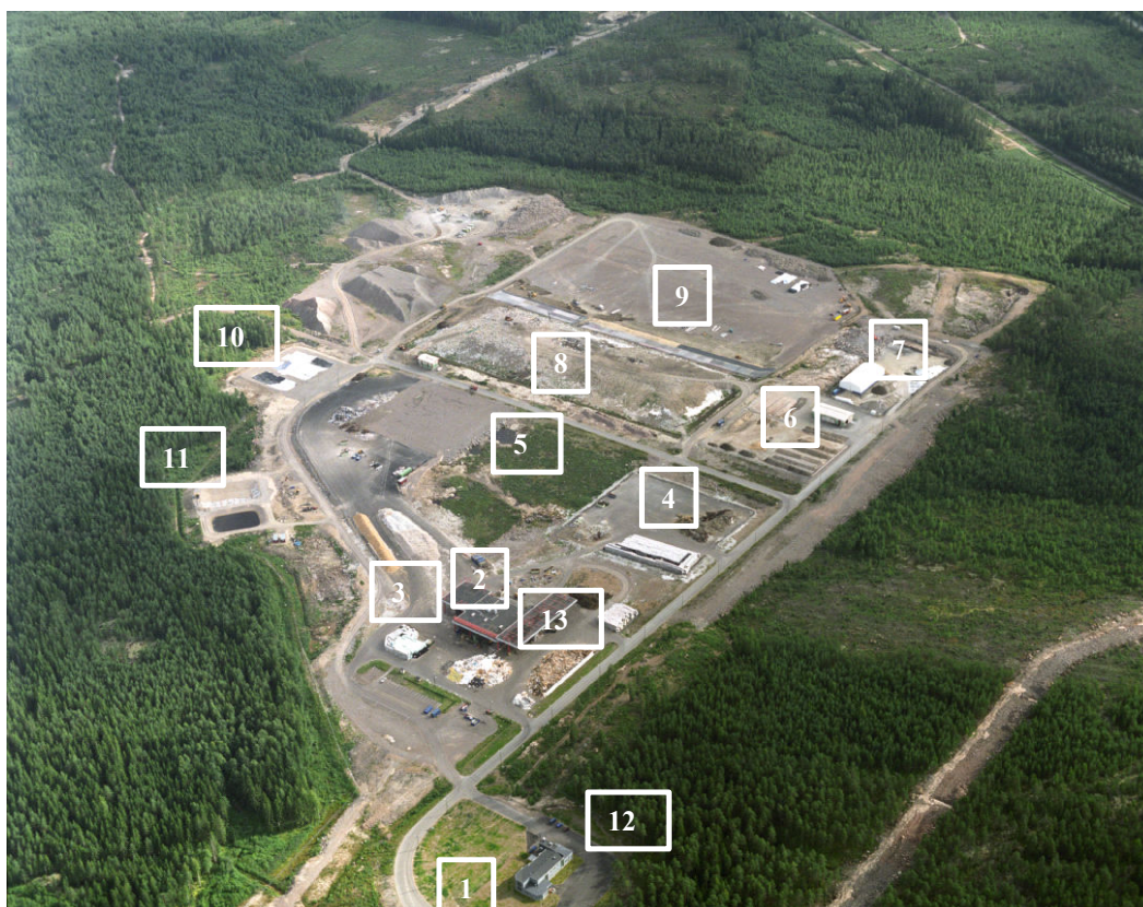
Kuva 3. Kymenlaakson Jäte Oy:n jätekeskuksen nykyiset toiminnot 1) Vaaka, vastaanotto (1999), 2) Murskauslaitos (1999), 3) Lajittelukenttä (2004), 4) Biojätteen kompostointi (2005), 5) Jätevesilietteen kompostointi (2005-2006), 6) Öljyiset maat (2002), 7) Pilaantuneet maat (2002), 8-9) Kaatopaikka (2001, 2004), 10) Nestemäisten jätteiden altaat (2004), 11) Tasausaltaat (1999, 2004), 12) Toimisto (2003), 13) Optinen erottelulaitos (1999, toiminta päättyi 2005)
