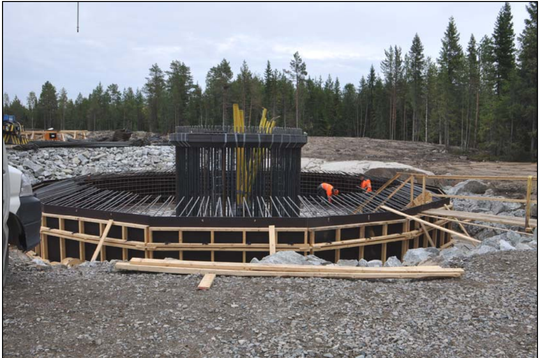
Kuva 10. Maavaraisen teräbetoniperustuksen rakentamisvaihe (Kuva: Leila Väyrynen / FCG).
