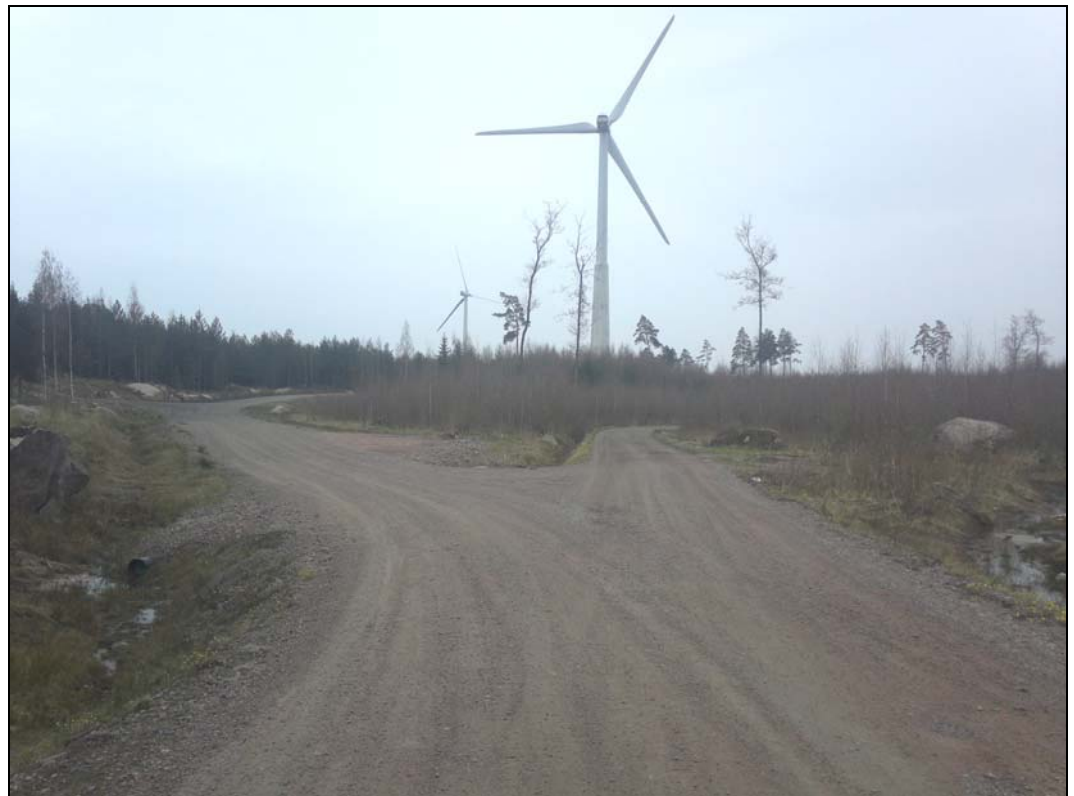
Kuva 16. Esimerkki tuulivoimapuiston rakennus- ja huoltoteistä Haminan Summassa. Teitä käytetään muun muassa betonin ja soran sekä voimaloiden komponenttien kuljetuksiin. Tuulivoimapuiston käyttövaiheessa teitä käytetään mm. vuosittaisissa huolloissa (Kuva: Mattias Järvinen / FCG).
