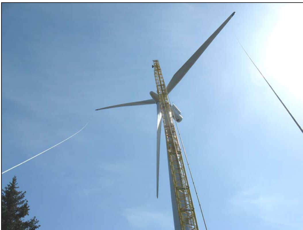
Kuva 22. Tuulivoimalan pystytysvaihe. Roottorin heilumista estetään kiinnit- tämällä apuköysi lapojen kärkeen (kuva: Suomen Hyötytuuli Oy).
