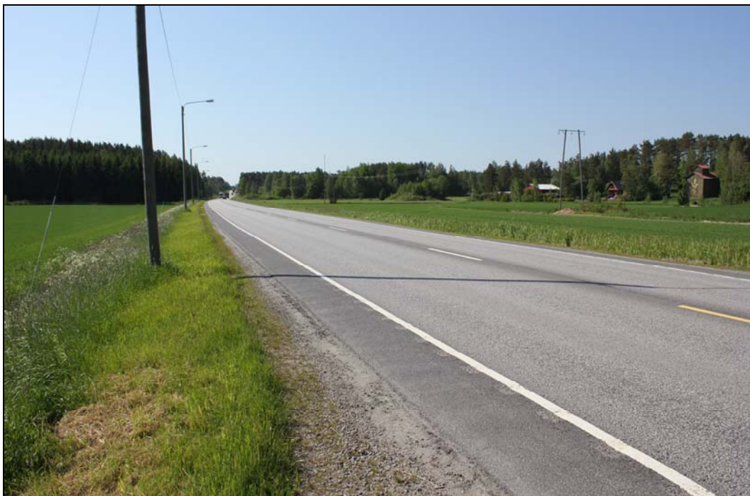
Kuva 38. Raumantie (valtatie 8) Idohen alueella etelän suuntaan katsottuna (Kuva: Mattias Järvinen / FCG).
