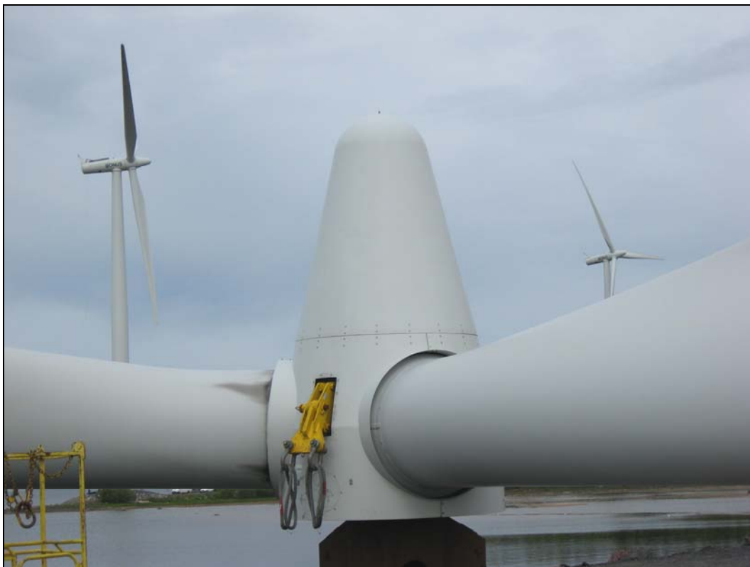
Kuva 21. Tuulivoimalan roottori kootaan maassa liittämällä lavat yhteen. Ku- vassa roottori on kiinni telineessä ennen nostamista torniin (kuva: Suomen Hyötytuuli Oy).
