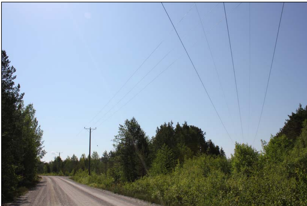
Kuva 18. Kakonjärven alueen tuulivoimapuisto kytketään puiston itäpuolella olevaan 110 kV voimajohtoon. Kuva otettu Untamontieltä, oikealla nykyinen tien ylittävä 110 kV ilmajohto ja vasemmalla tietä myötäilevä 20 kV ilmajohto (Kuva: Mattias Järvinen / FCG).
