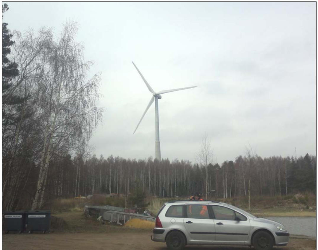
Kuva 9. Esimerkki 3 MW tuulivoimalasta (turbiinimalli: WinWind). Kuva on otettu Haminan Summan alueen tuulivoimapuistosta (Kuva: Mattias Järvinen / FCG).
