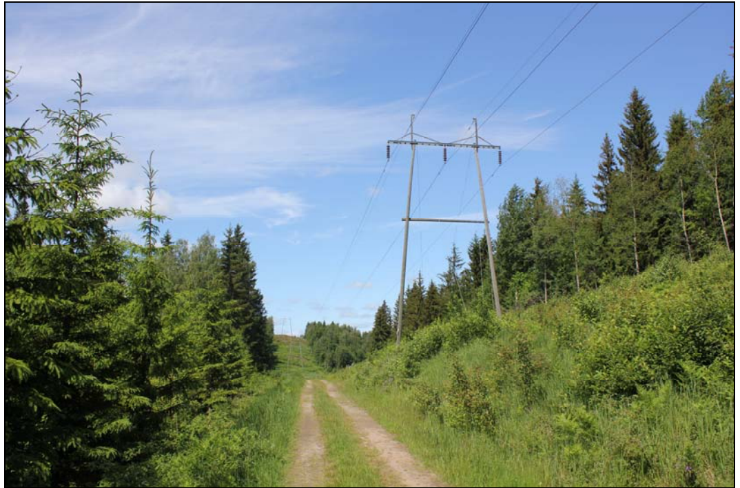
Kuva 20. Esimerkki 110 kilovoltin ilmajohdosta. Johtoaukealla esiintyy yleensä puun taimia ja pensasmaista kasvillisuutta (Kuva: Mattias Järvinen / FCG).
