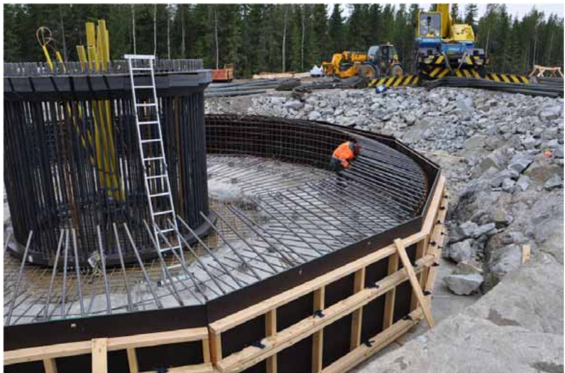
Kuva 5.11. Tuulivoimalan perustusten rakentamista. (Kuva: Leila Väyrynen, FCG)
