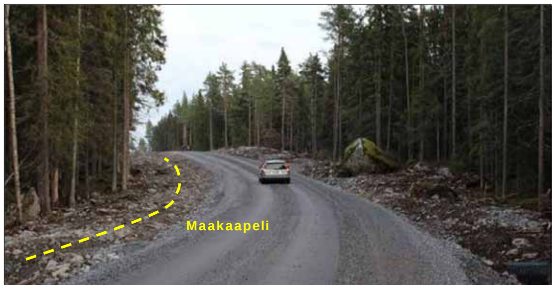
Kuva 5.7. Esimerkki tuulivoimapuiston rakennus- ja huoltotiestä. Teitä käytetään muun muassa betonin ja soran sekä voimaloiden komponenttien kuljetuksiin. Tuulivoimapuiston käyttövaiheessa teitä käytetään mm. vuosittaisissa huolloissa. Maakaapelin oja on sijoitettu tien vasemmalle puolelle (Kuva: Hans Vadbäck / FCG).
