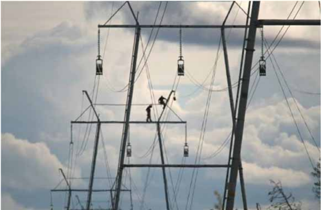
Kuva 5.12. 220 kV voimajohdon rakentamista. (Kuva: Ville Suorsa, FCG)
