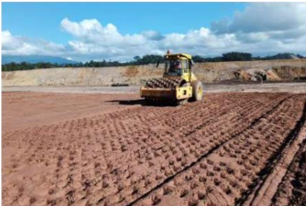
Kuva 4-12. Esimerkki kuivaläjitetyn rikastushiekan tiivistämisestä. (PT-Agincourt Resources 2026)
