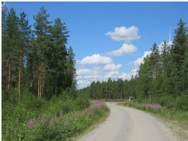
Kuva 31. Yhtymäkohta VE1B ja VE1C Savimäen tuulivoimapuistossa
