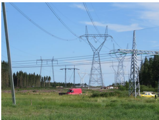
Kuva 33. Haapajärven Pysäysperän uusi sähköasema (rakenteilla)
