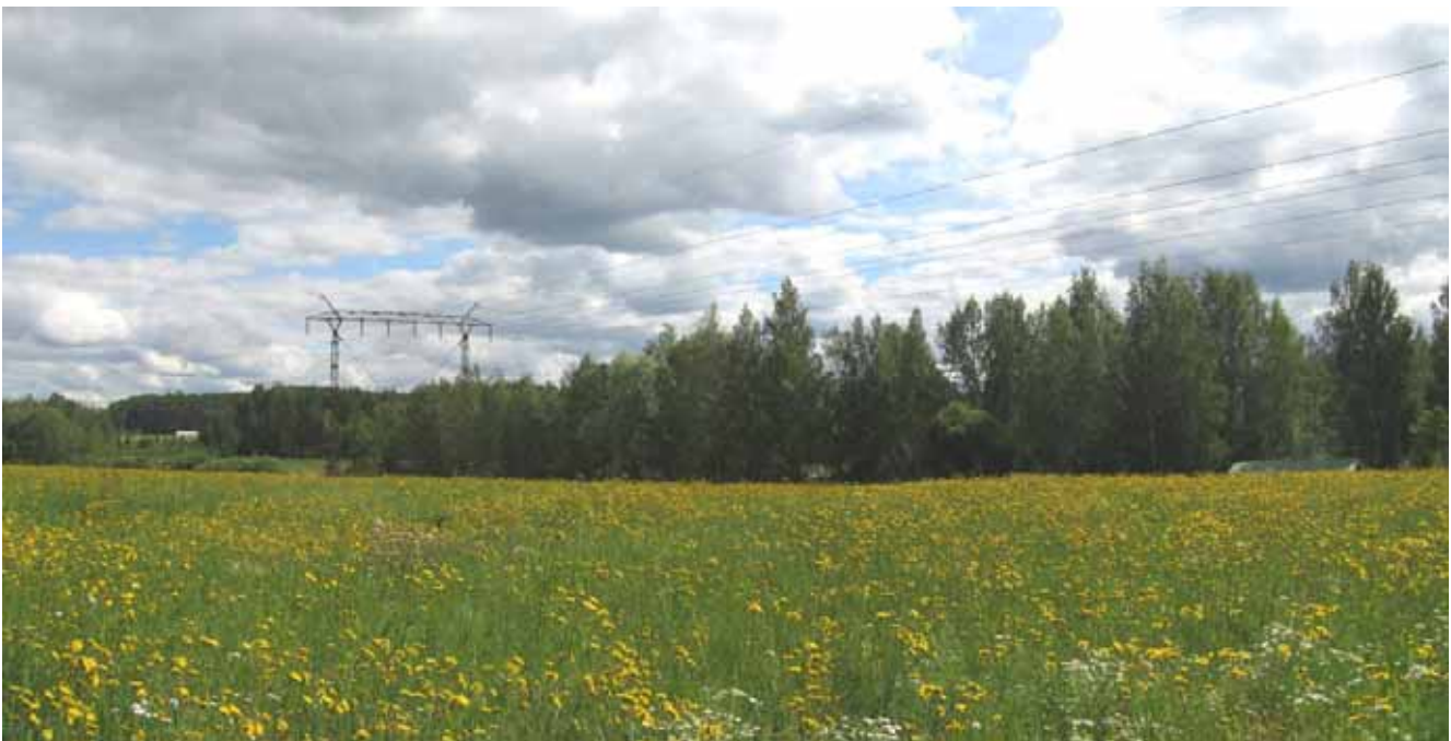
Kuva 28. Janakkalan Toivajoen alueen nykyinen 2x110 kV voimajohto.
