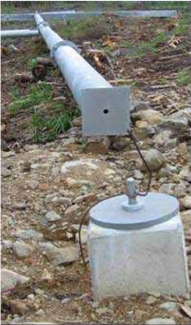
Kuva 10. Pylväsjalan perustus ja maadoituselektrodiin.
