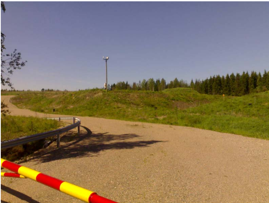
Kuva 8.12. Viereisen kiinteistön suljettu, maisemoitu kaatopaikka Lemuntieltä kuvattuna.
