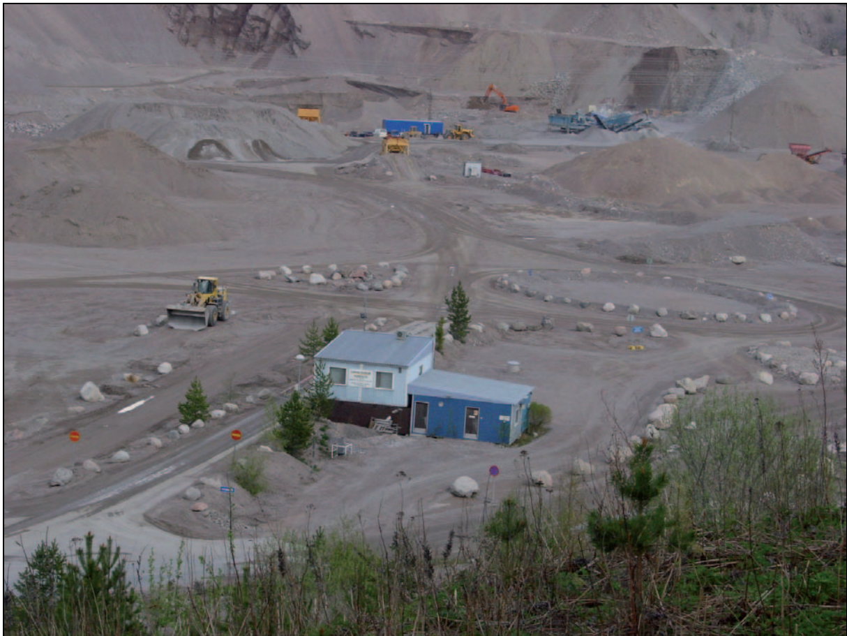
Kuva 10. Renkomäen vaaka-asema. Taustalla näkyy myös murskaus- ja seulonta-asema.
