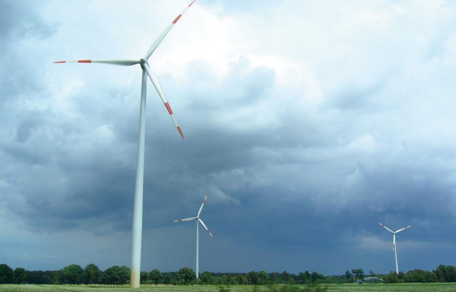
Kuva 2-14. Esimerkkikuva tuulivoimalan päivämerkinnöistä.
