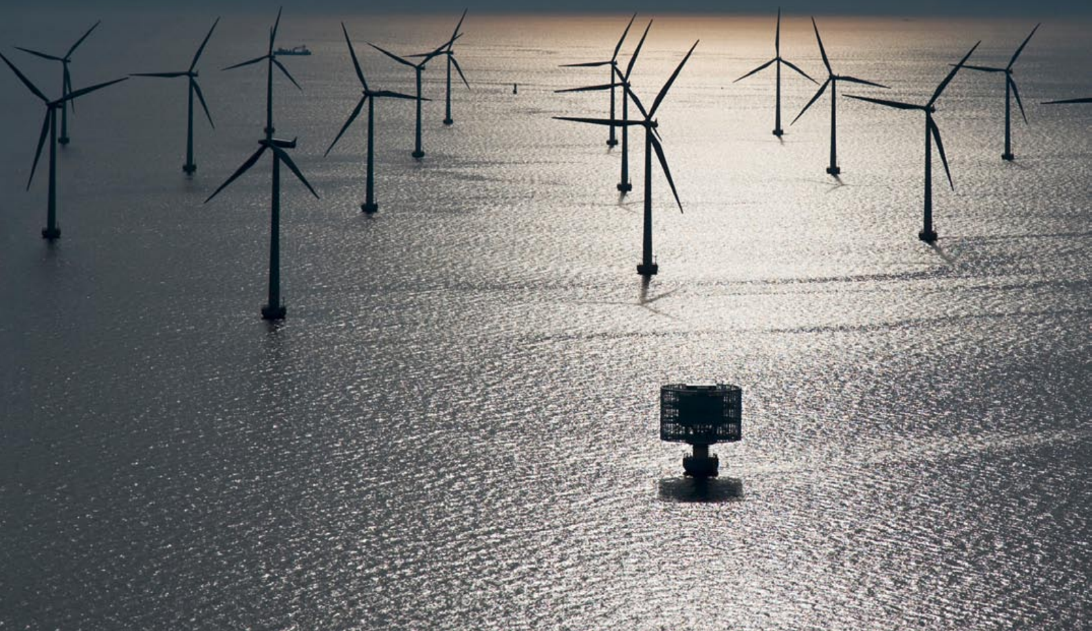
Kuva 2-11. Merelle perustettava sähköasema. Kuva Lillgrundin merituulivoimapaistosta Ruotsista.
