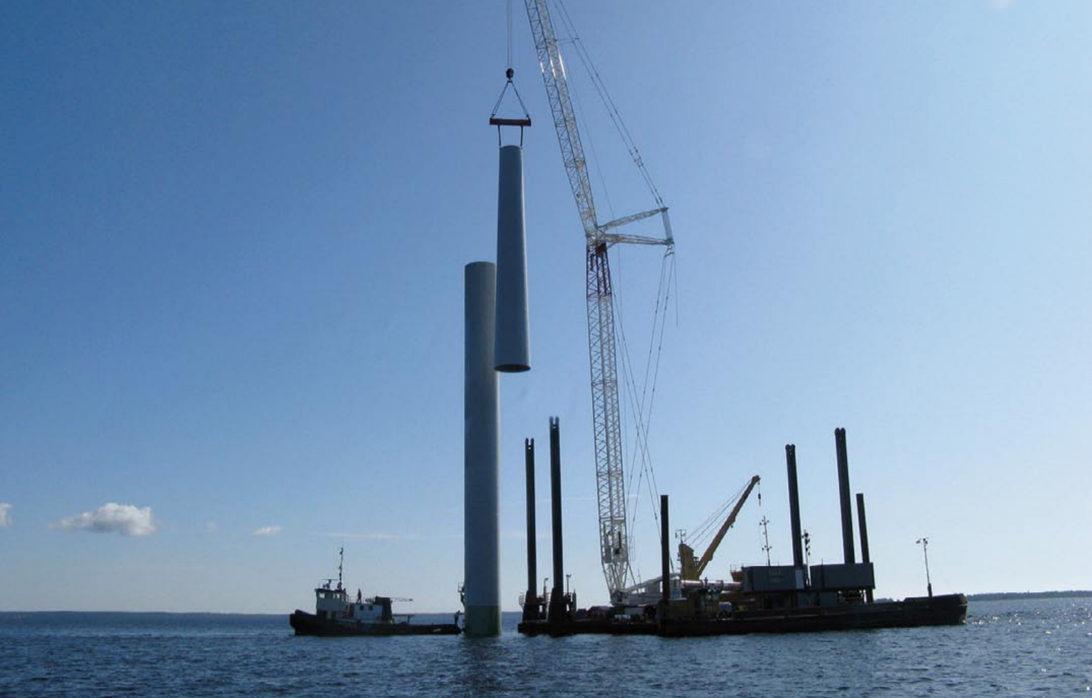
Kuva 2-17. Voimalaitostornin pystytystyö käynnissä Ajoksen koeperustushankkeessa kesällä 2009. Kuva: Kai Tirkkonen
