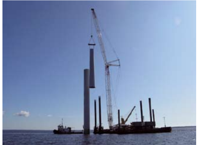
■ Kuva 3-3. Voimalaitostornin pystytystyö käynnissä Ajoksen koeperustushankkeessa kesällä 2009.
