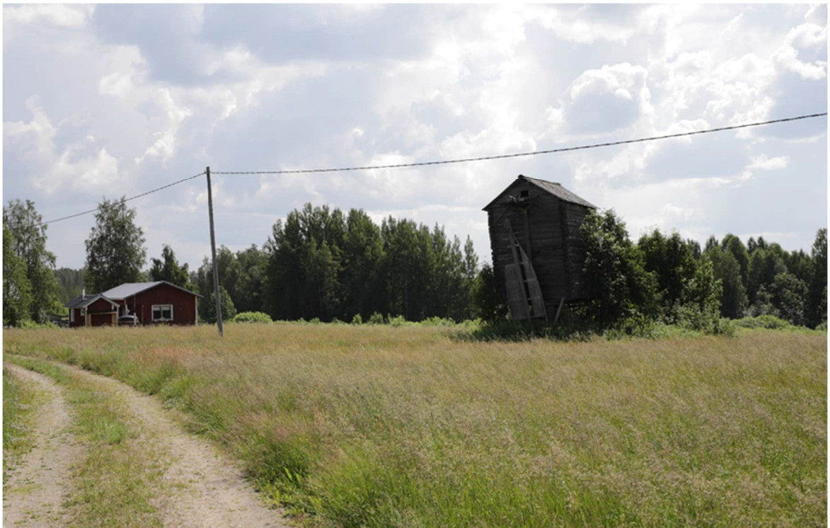
Kuva 1.21. Valokuva Taipaleenharjun asutuksesta. Kuvassa näkyy myös maakunnallisesti arvokas vanha tuulimylly. Tuulimyllyjä on yhteensä kolme ja ne muodostavat alueelle omaleimaisuutta antavan maamerkinomaisen kokonaisuuden.
