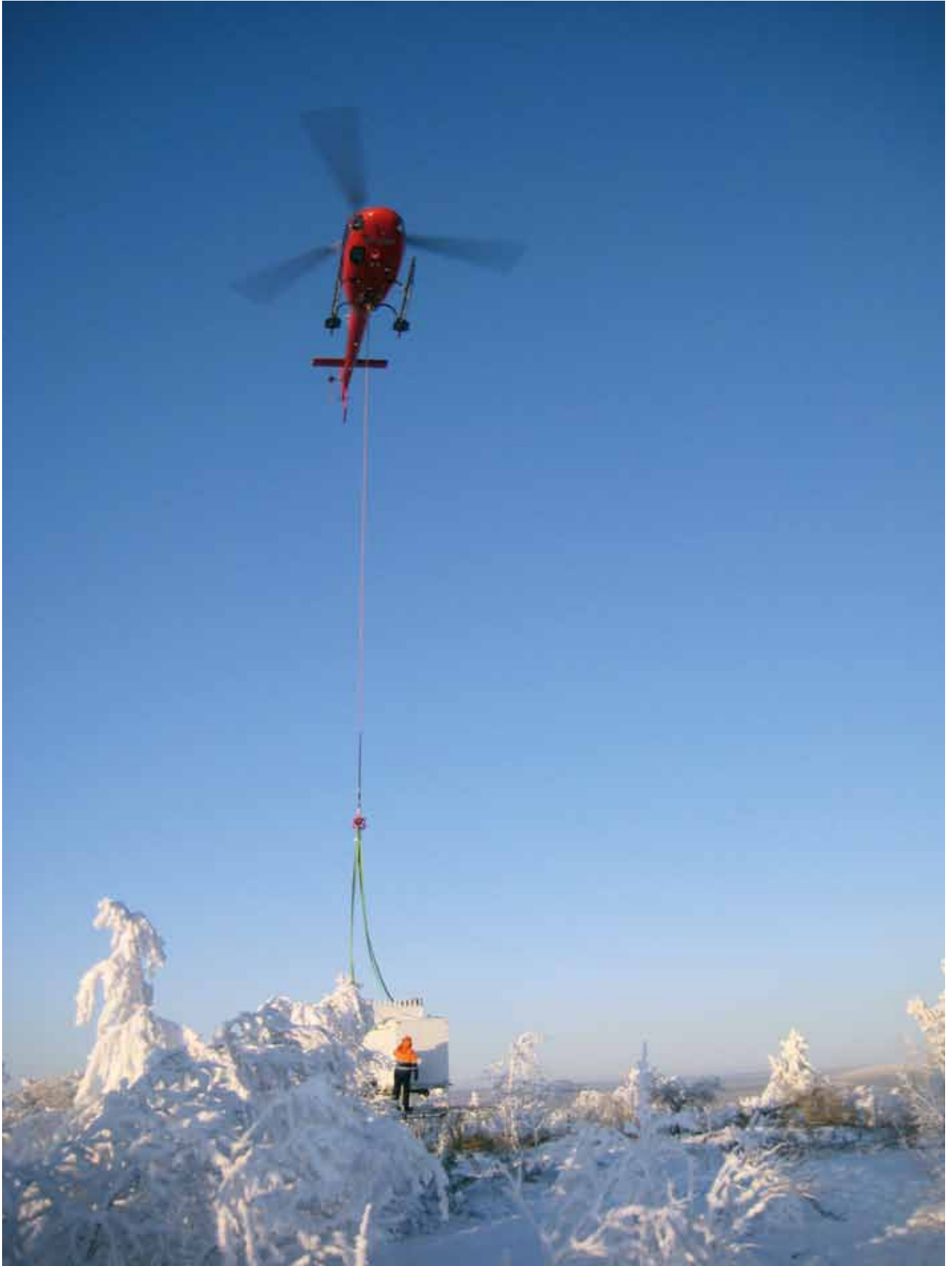
Kuva 6-6. Sodar-laitteiston asennus Mielmukavaaran huipulle (kuva: Jussi Sarvela).
