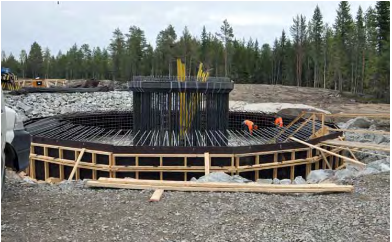
Kuva 5-6. Tuulivoimalan perustusten rakentamista (Kuva: Leila Väyrynen / FCG).
