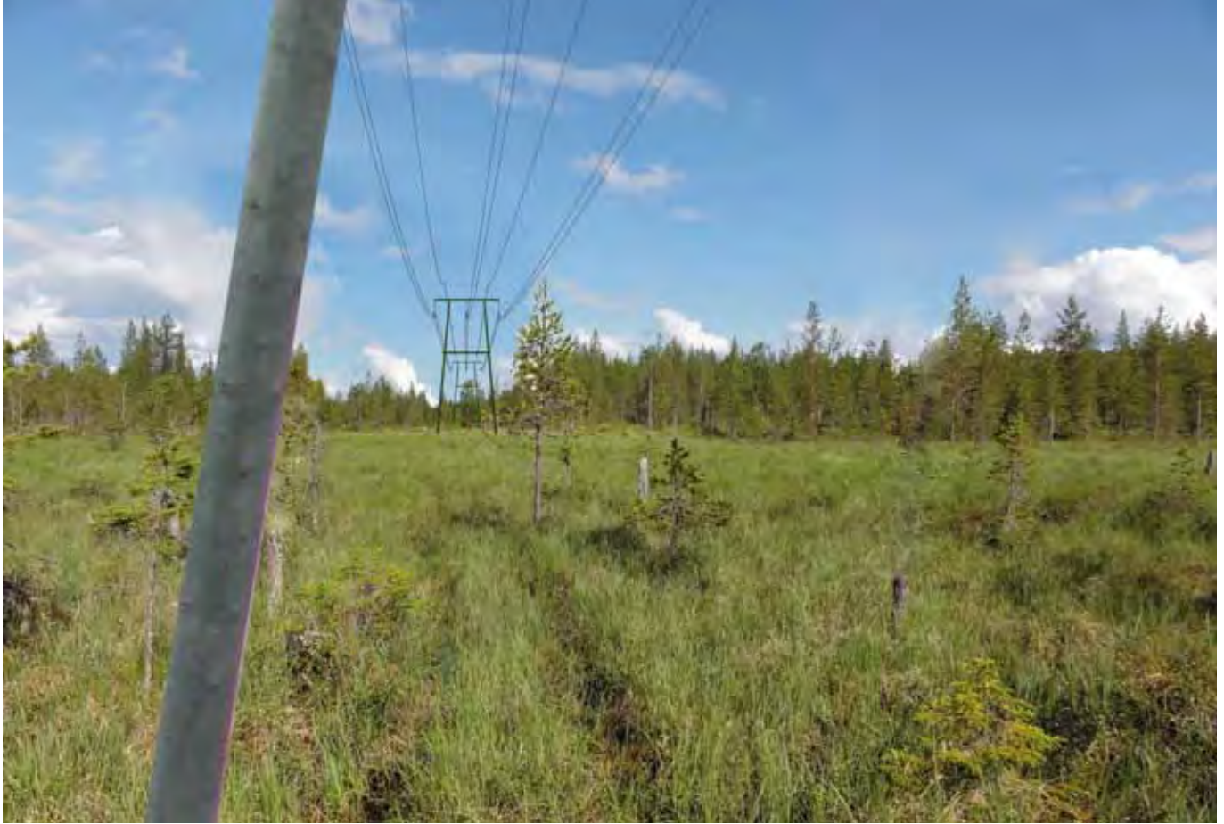
Kuva 9-21. Valokuvaseite kuvauspisteestä I. Rakennettava 110 kV voimajohto.
