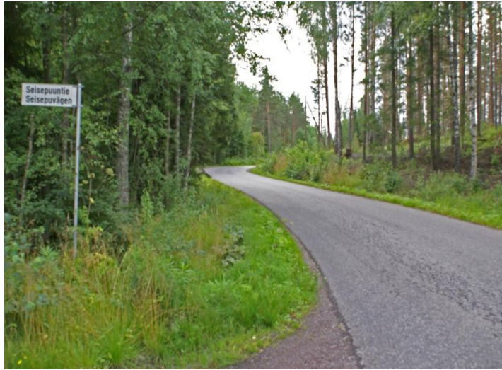
Kuva 2. Näkymä Seisepuuntien liittymästä etelään Brusaksentielle. Sisäkaarteessa vesakkoa, joka rajoittaa näkymiä.
