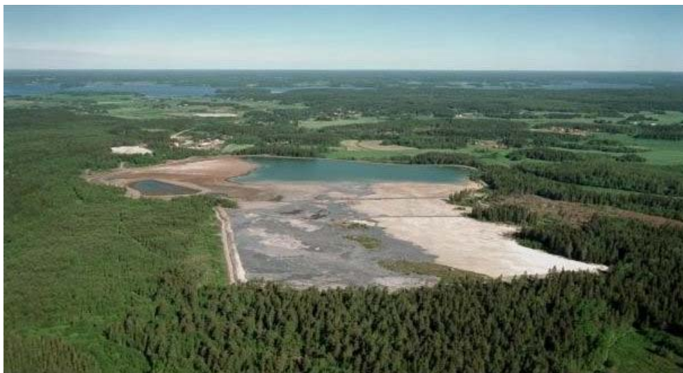
Kuva 4.12 Vammalan kaivoksen rikastushiekka-allas.
