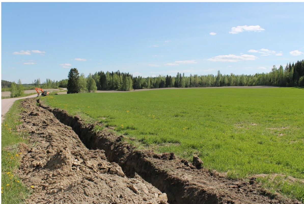
Kuva 5-7. Esimerkkikuva maakaapelin kaapeliojan kaivuutyöstä, Ratiperän tuulivoimapuisto Jämijärvellä (Kuva: ABO Wind Oy).
