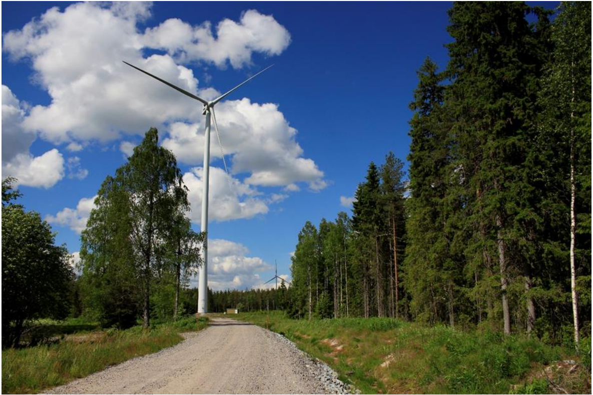
Kuva 5-5. Esimerkkikuva tuulivoimapuiston huoltotiestä, Sauvinmäen tuulivoimapuisto Haapajärvellä (Kuva: ABO Wind Oy).
