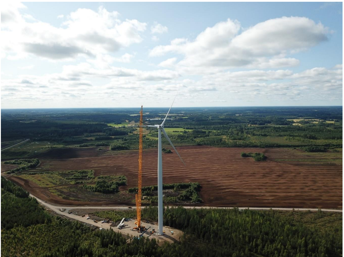
Kuva 5-6. Esimerkkikuva maankäytöstä tuulivoimalan rakentamisvaiheessa, Ratiperän tuulivoimapuisto Jämijärvellä (Kuva: ABO Wind Oy).
