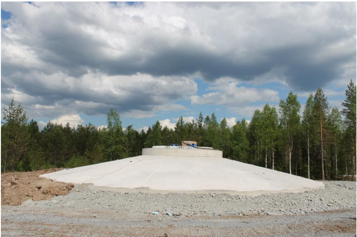
Kuva 5-3. Esimerkkikuva tuulivoimalan teräsbetoniperustuksesta, Silovuoren tuulivoimapuisto Pyhäjoella (Kuva: ABO Wind Oy).
