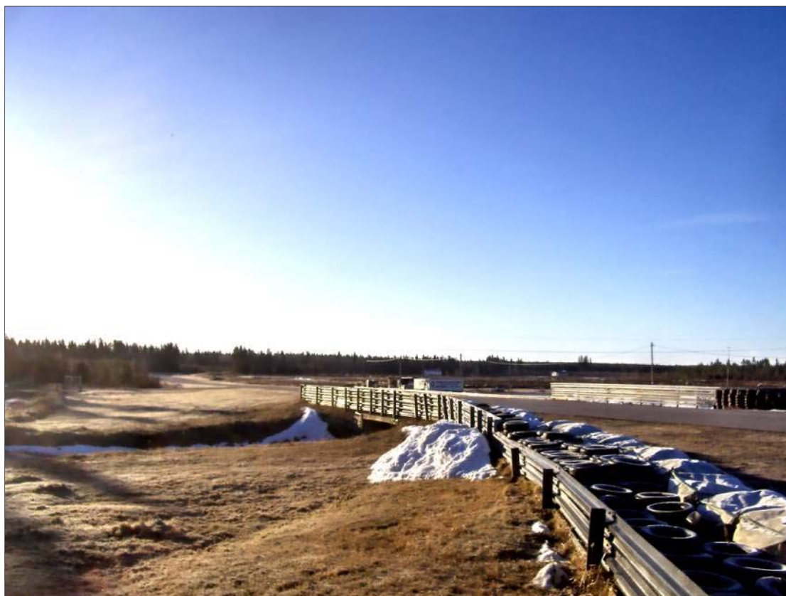
Kuva 4. Näkymä Botniaring-radalta etelään. (LL/25.04.2013)
