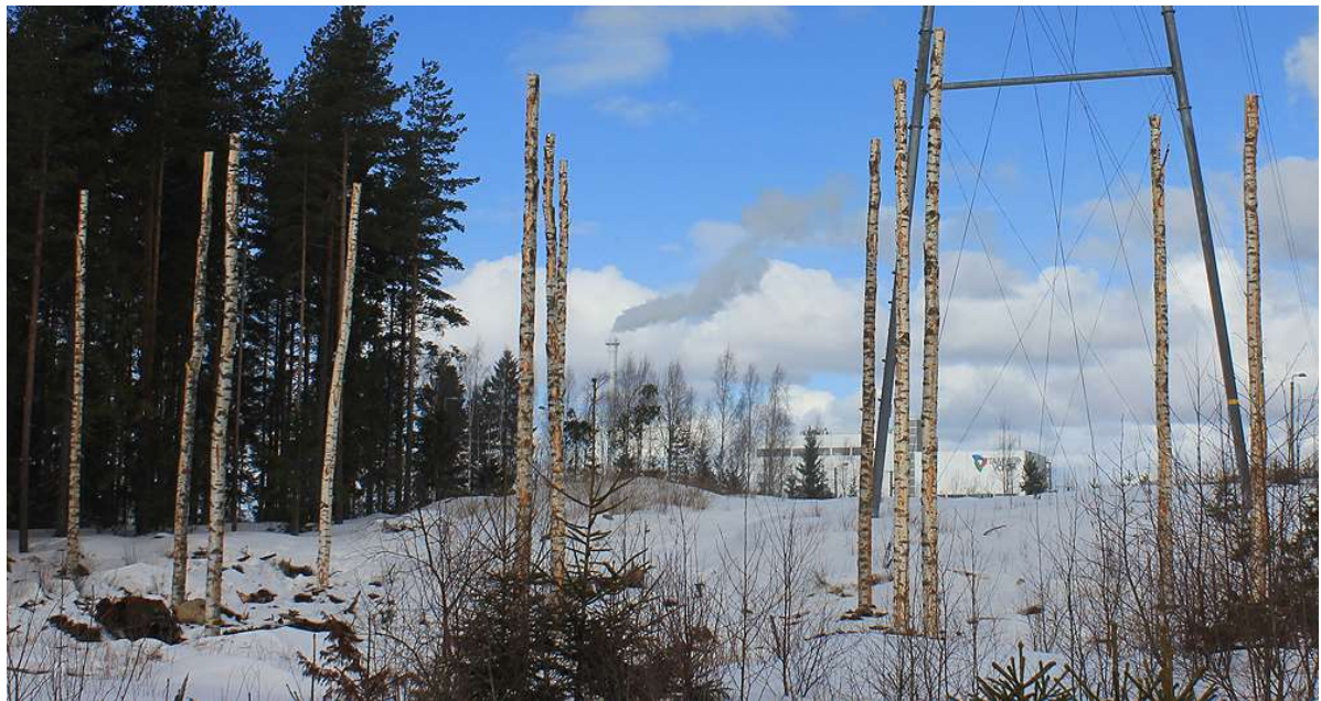
Kuva 56. Tampereen Sähköverkko Oy:n rakentama hyppytolppakenttä liito-oravia varten Tammervoiman hyötyvoimalaitoksen läheisyydessä. (kuva: Tampereen Sähköverkko)
