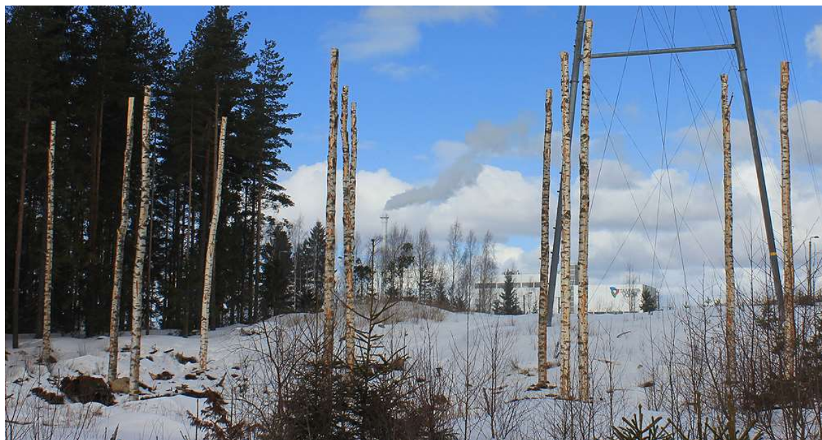
Figur 56. Tampereen Sähköverkko Oy har byggt hoppstolpar för flygekorrar på en kraftledningsgata i närheten av Tammervoima kraftverk. (foto: Tampereen Sähköverkko)
