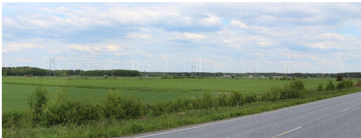
Figur 65. Visualisering från en plats öster om Närpes centrum, vid Karlåvägen (utdrag ur fotomontage nr 10 i bilagan) där avståndet till vindkraftsparken är cirka 4 km. Väder- och belysningsförhållandena påverkar kraftigt vindkraftverkens synlighet i landskapet och de ljusa tornen kan försvinna i landskapsbilden.
