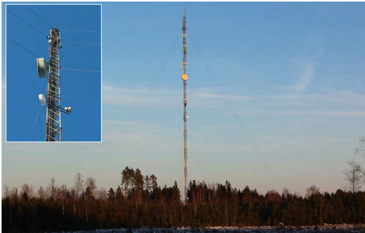
Figur 14-4. Telia-Soneras 105 meter höga länkstation (Munsolb 6 559 3529) är belägen intill projektområdet. Enligt Telia-Sonera utlåtande påverkas mastens funktion inte av Sandbacka vindkraftspark.
