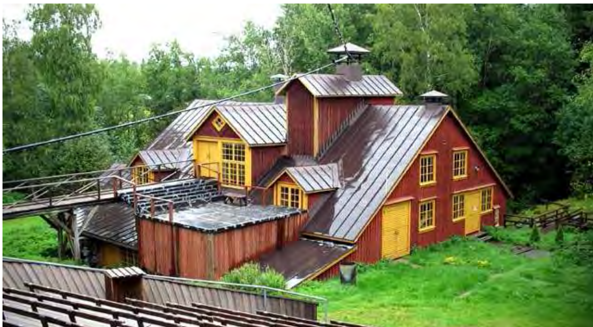
Figur 15-4. Kimo bruk och Oravais industriområden, Vörå. Hammarsmedja som byggts om till kvarn vid Nedre hammaren vid Kimo bruk. Sommartid fungerar kvarnen som sommarteater. Bilderna: MV/RHO Maria Kurtén 2007.
