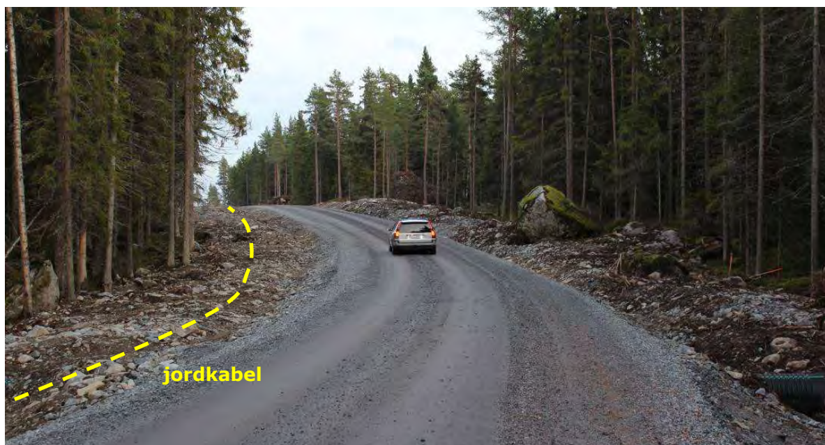
Figur 4-5. Exempel på bygg- och serviceväg för vindkraftsparken. Vägarna används bland annat för transport av betong och grus samt kraftverkens komponenter. I driftskedet används vägarna bl.a. för årlig service. Diket för jordkabeln finns på vägens vänstra sida (foto: Hans Vadbäck/FCG).
