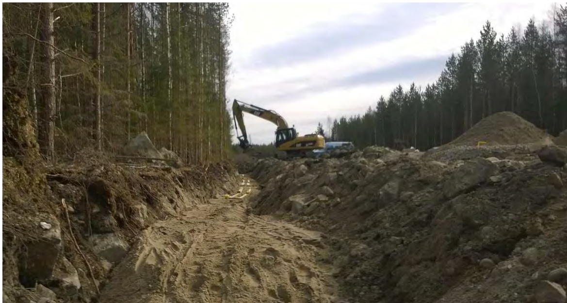
Figur 4-9. Installation av jordkablarna sker normalt intill servicevägarna.
