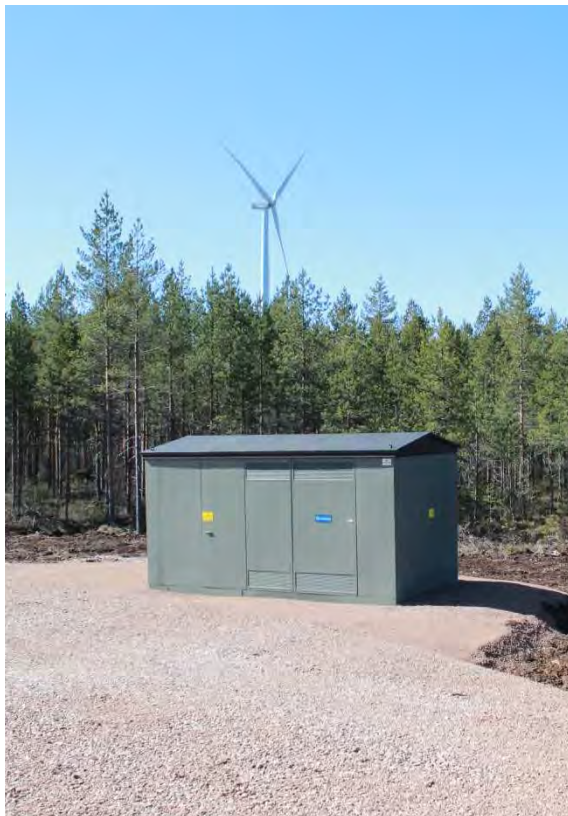
Figur 4-7. Exempel på vindkraftsverkets transformator placerat direkt intill kraftverket och jordkabelfördelningsskåp till höger.
