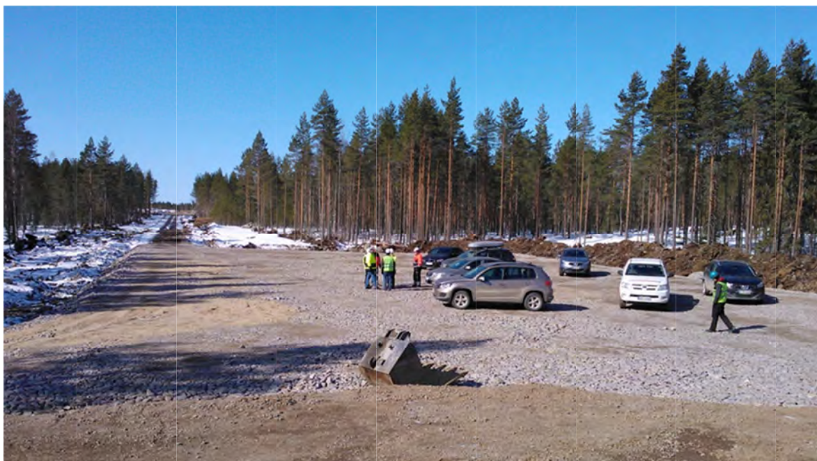
Figur 4-10. Monterings- och lyftområde för ett vindkraftverk.
