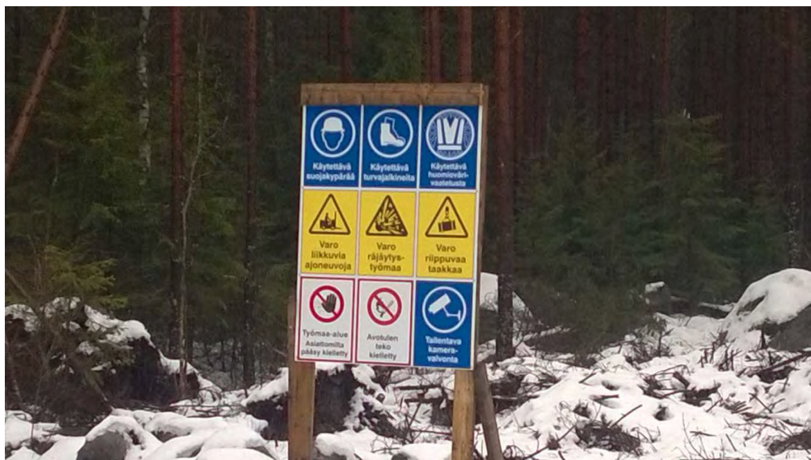
Figur 4-12. Exempel på säkerhetsföreskrifter under byggnadsskedet.
