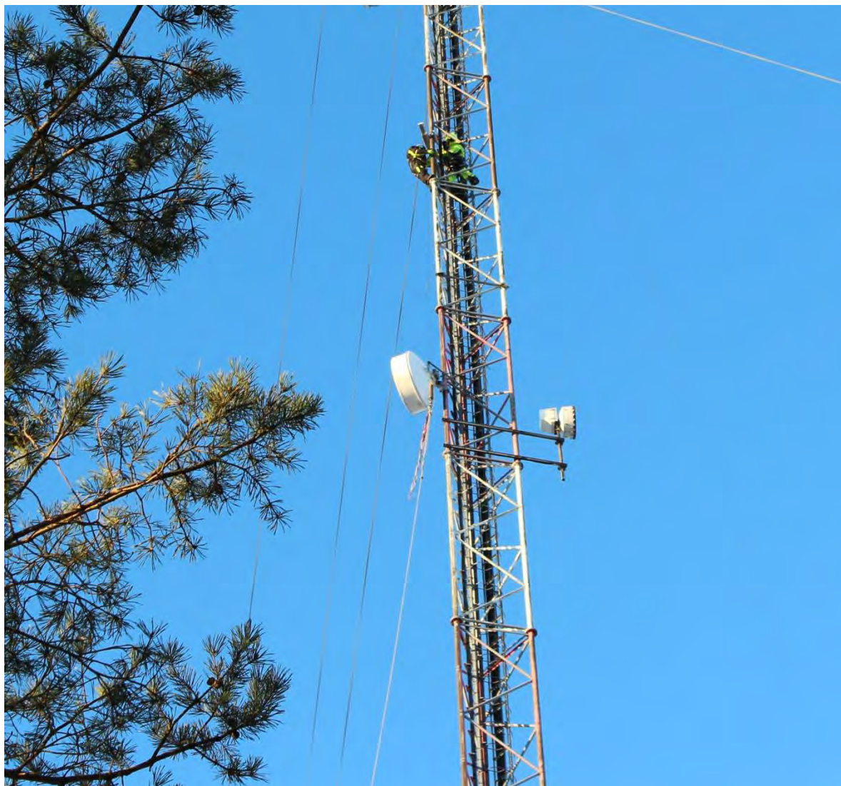
Figur 4-2. Installation av vindmätningstrustning i projektområdet inleddes i januari 2014.
