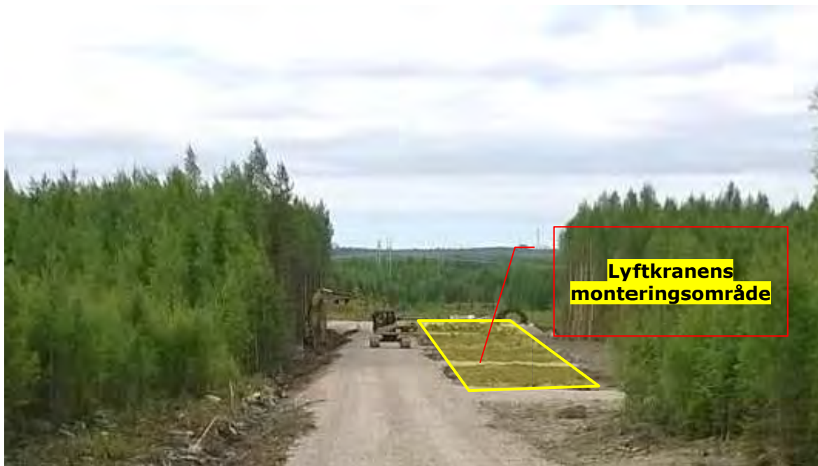
Figur 4-11. Huvudsakliga lyftkranens monteringsområde intill servicevägen
