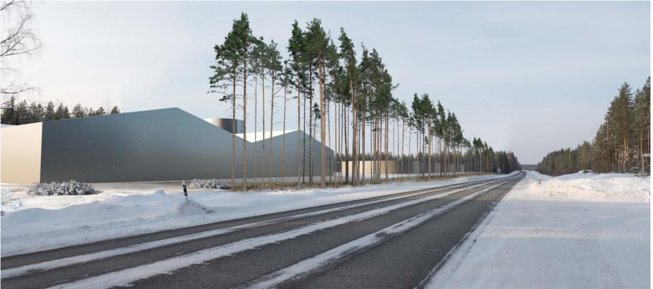
Kuva 75. Pyhäsalmentie, näkymä lännen suuntaan. Vaihtoehdossa, jossa laitosalue sijaitsee Pyhäsalmentien eteläpuolella, se näkyy selvästi tiemaisemassa. Tieltä avautuu esteettömiä näkymiä laitosalueelle.
