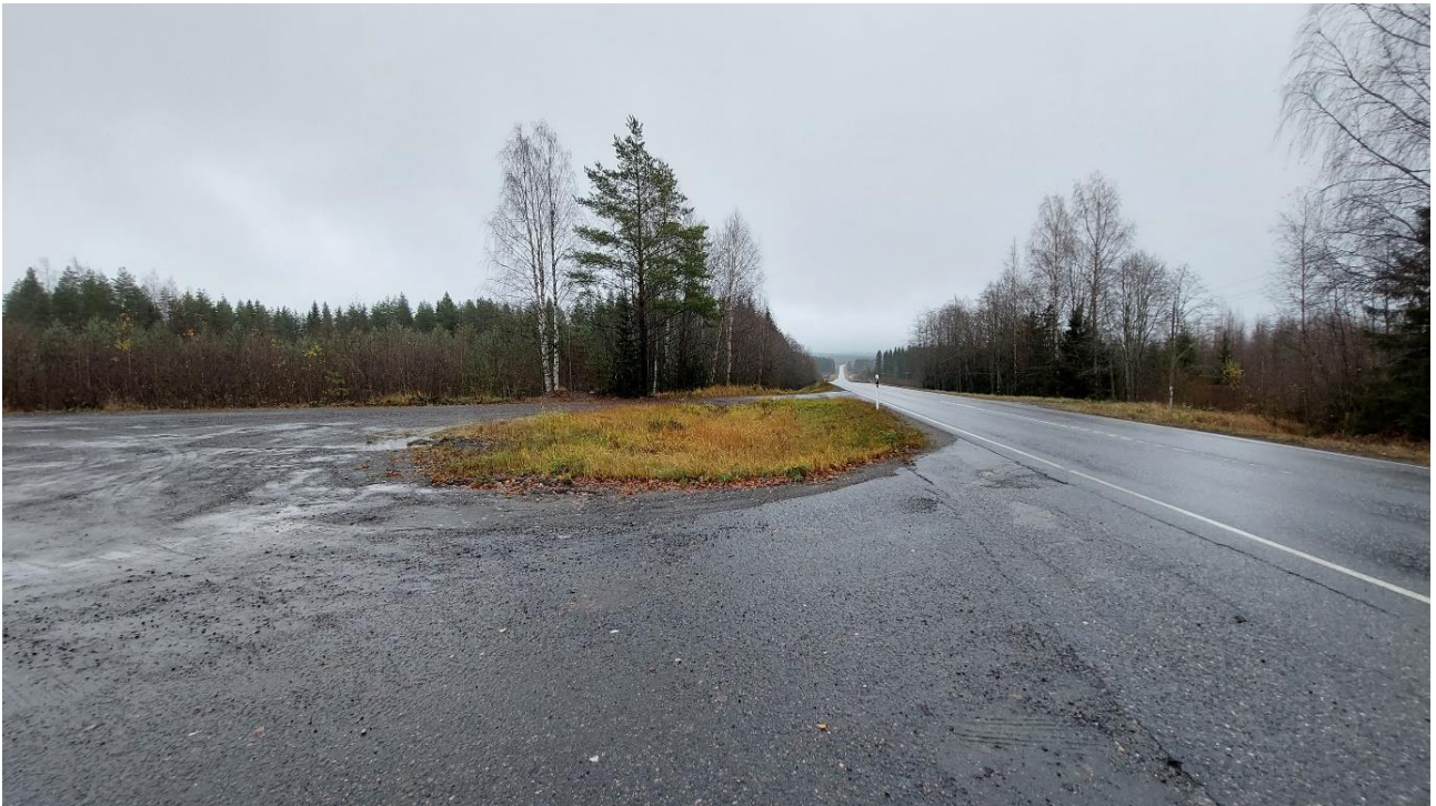
Kuva 52. Valokuva Nyteikönahon VE2 läntisen maantieliittymän risteysalueelta itään.
