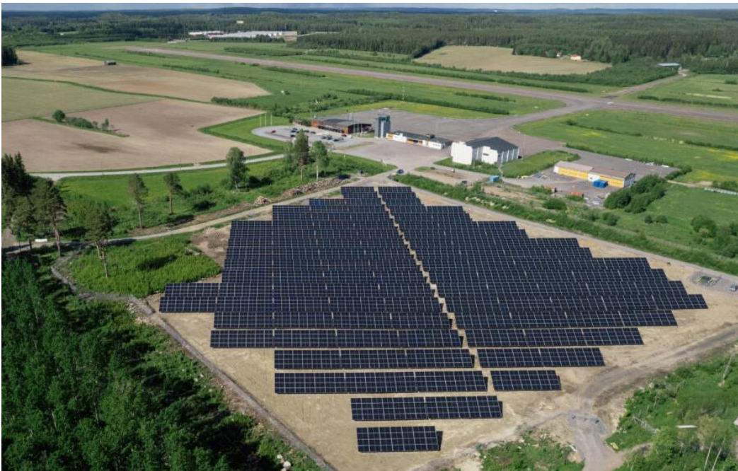
Kuva 9. Esimerkkikuva aurinkovoimalasta. Kuvassa Ilmatar Energy Oy:n Joroisten lentokentän alueen aurinkovoimapuisto. Kyseisen alueen koko noin 6 ha ja kokonaisteho 5 MWp. Kuva: Ilmatar Energy Oy
