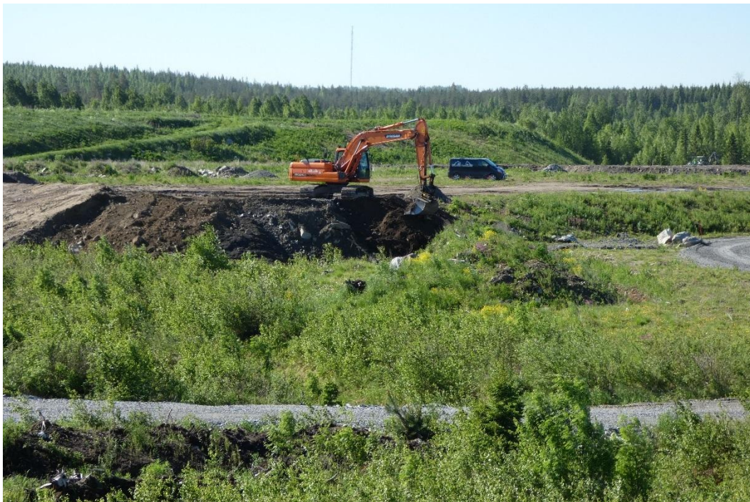
Kuva 7. Kaivuri tekemässä luiskaa (Sweco Ympäristö Oy, 2017).
