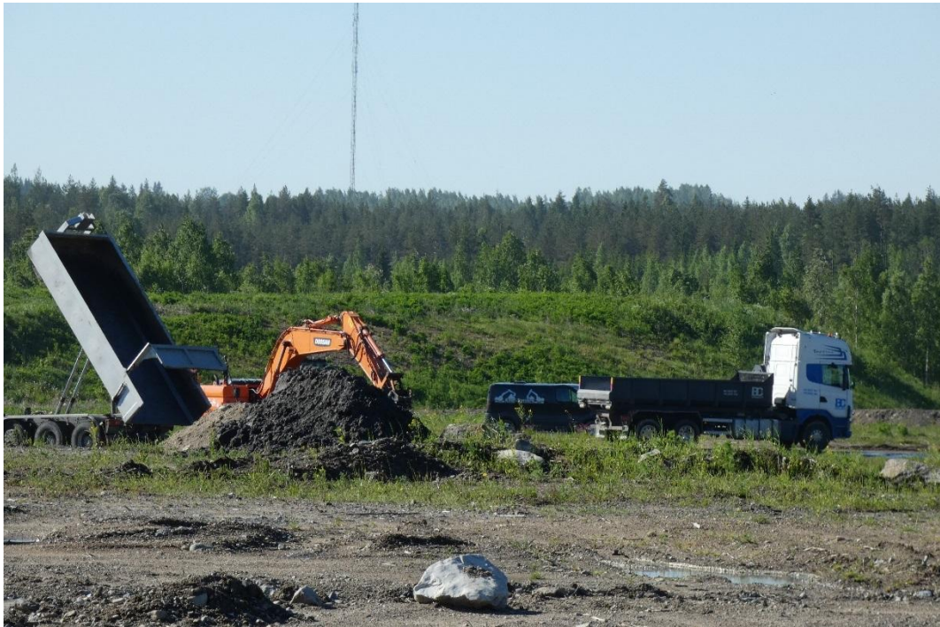
Kuva 5. Kuorma-auto tyhjentämässä ja kaivinkone tasoittamassa kuormaa (Sweco Ympäristö Oy, 2017).
