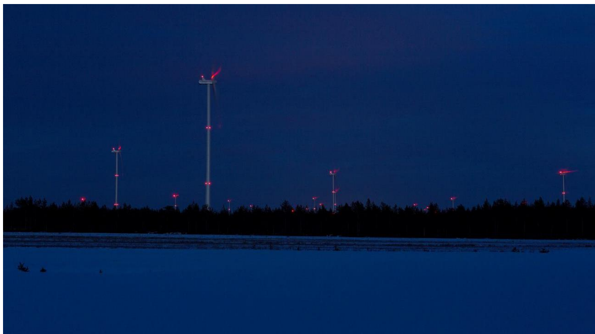
Bild 4.5 Fasta röda flyghinderljus (FCG Rakennettu Ympäristö Oy).
