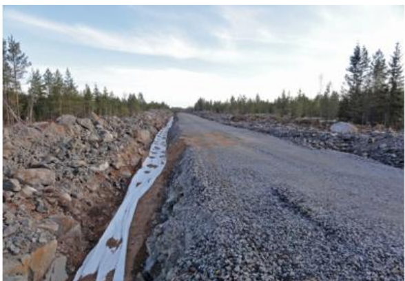
Bild 4.11 Jordkablarna sänks ner i anslutning till servicevägar (FCG Rakennettu Ympäristö Oy).
