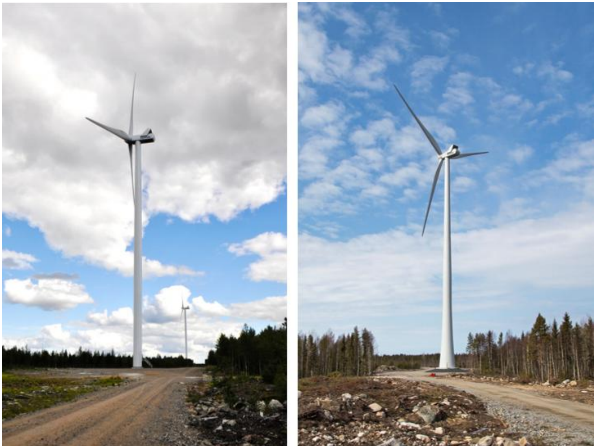
Bild 4.2. Till vänster ett exempel på ett stålcylindertorn och till höger ett hybridtorn (FCG Rakennettu Ympäristö Oy).
