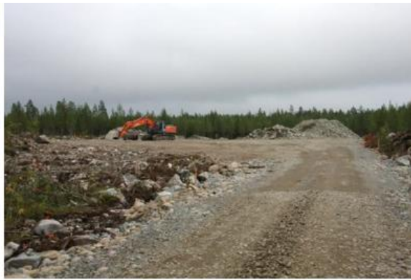
Bild 4.10 Byggnad av vindkraftsparken inleds med att bygga vägar och lyftområden (FCG Rakennettu Ympäristö Oy).
