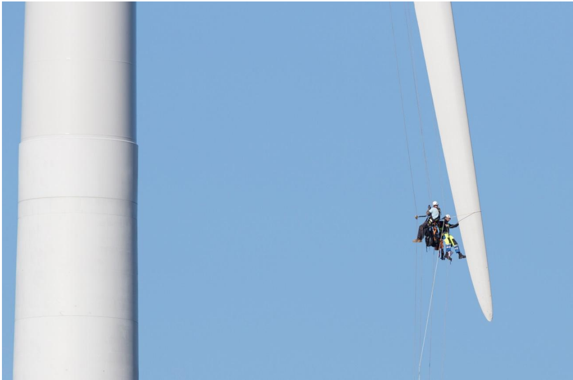
Bild 4.16 Vindkraftverk underhålls (FCG Rakennettu Ympäristö Oy).
