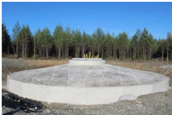
Bild 4.12 Byggande av vindkraftverkets fundament (FCG Rakennettu Ympäristö Oy).
