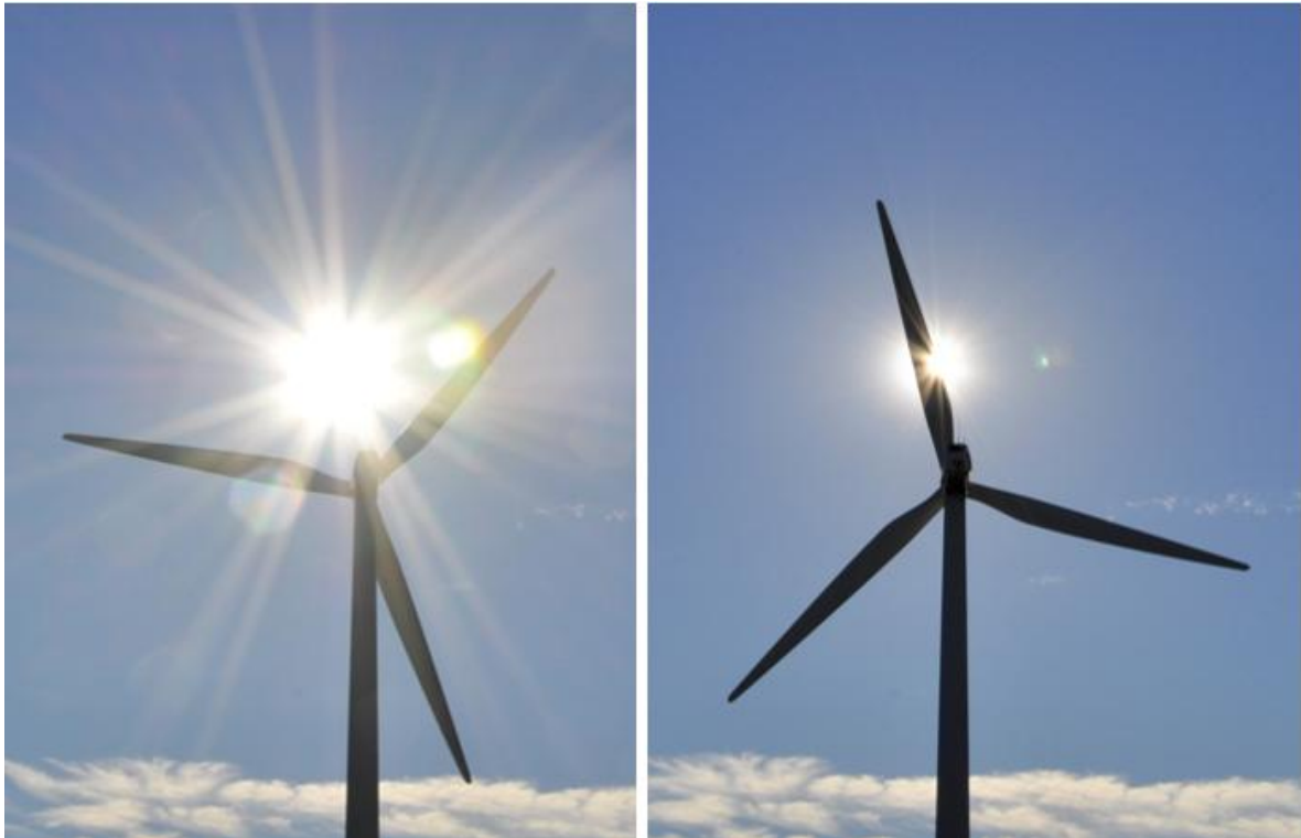
Bild 18.14 Vindkraftverkens rotorblad orsakar blinkande ljus och rörliga skuggor vid soligt väder.
