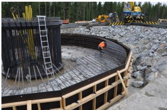
Bild 4.12 Byggande av vindkraftverkets fundament (FCG Rakennettu Ympäristö Oy).
