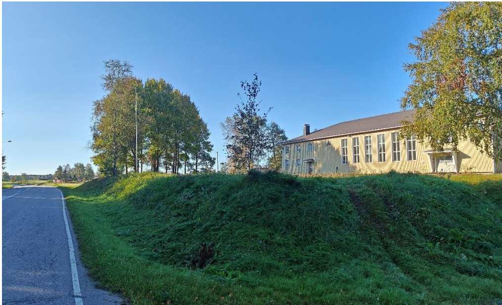
Bild 8.28 Vy i riktning mot kraftverken. Petalax UF till höger.
