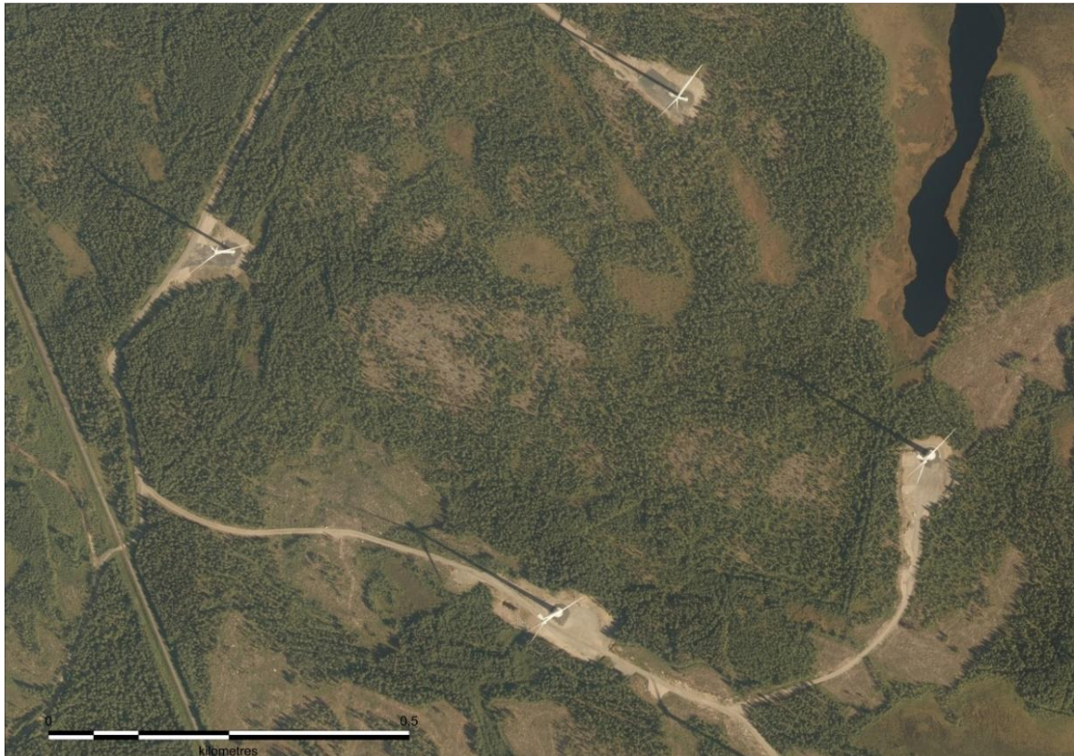
Bild 4.1 Exempelbild på verksamt vindkraftsområde. Servicevägar och resningsfält har byggts för vindkraftverken. I omgivningen av vindkraftverken och mellan dem har den tidigare markanvändningen bevarats oförändrad.
