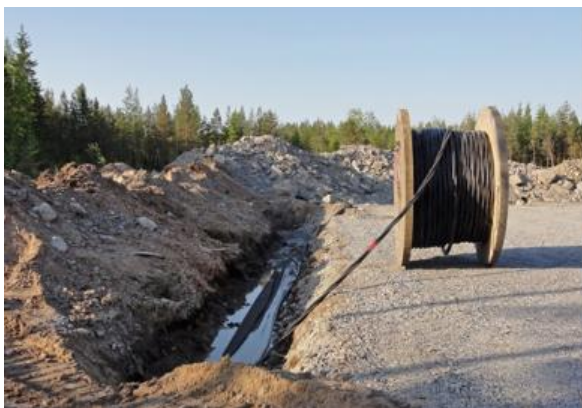
Bild 4.11 Jordkablarna sänks ner i anslutning till servicevägar (FCG Rakennettu Ympäristö Oy).
