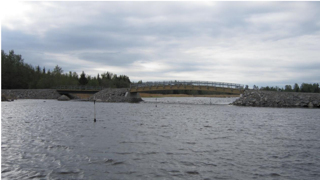
Bild 3-2 Exempel på en låg bågbro, Svartöhålets bro, Malax.
