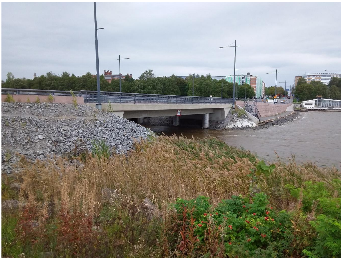
Bild 3-8. Exempelbild på spännarmerad betongbalkbro. På bilden visas Vasklotsbron i Vasa. Foto: Ilkka Redman.
