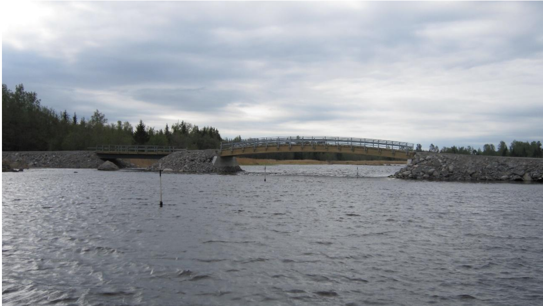
Kuva 3.2 Esimerkki matalasta kaarisillasta, Svartöhåletin silta, Maalahdessa.
