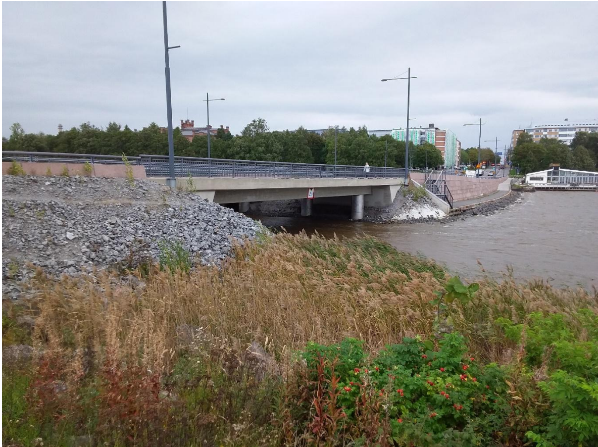
Kuva 3.8 Esimerkkikuva jännitetystä betonisesta ulokepalkkisillasta. Kuvassa Vaasan Vaskiluodon silta. Kuvaja: Ilkka Redman.
